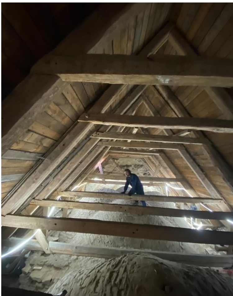
Långhuset före åtgärder och under arbete.
