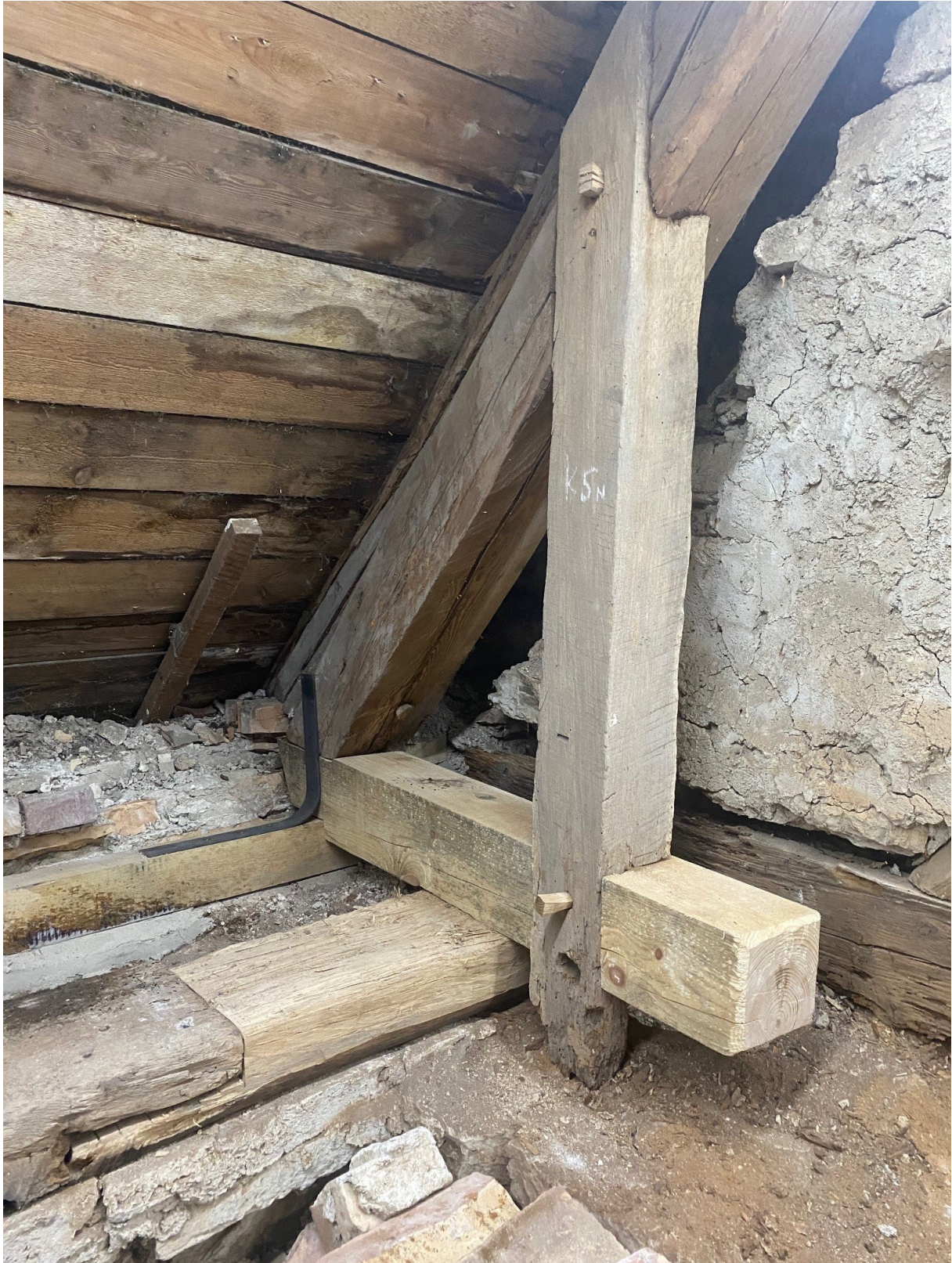
Efter åtgärder K5 N, inre och yttre lejd, stödben och tass.
