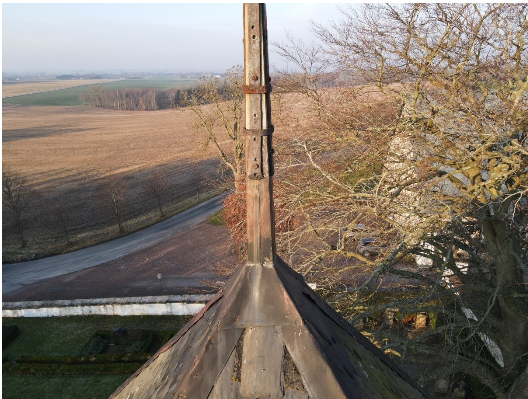
Spiran på torntaket före nedmontering. Drönbilder.
