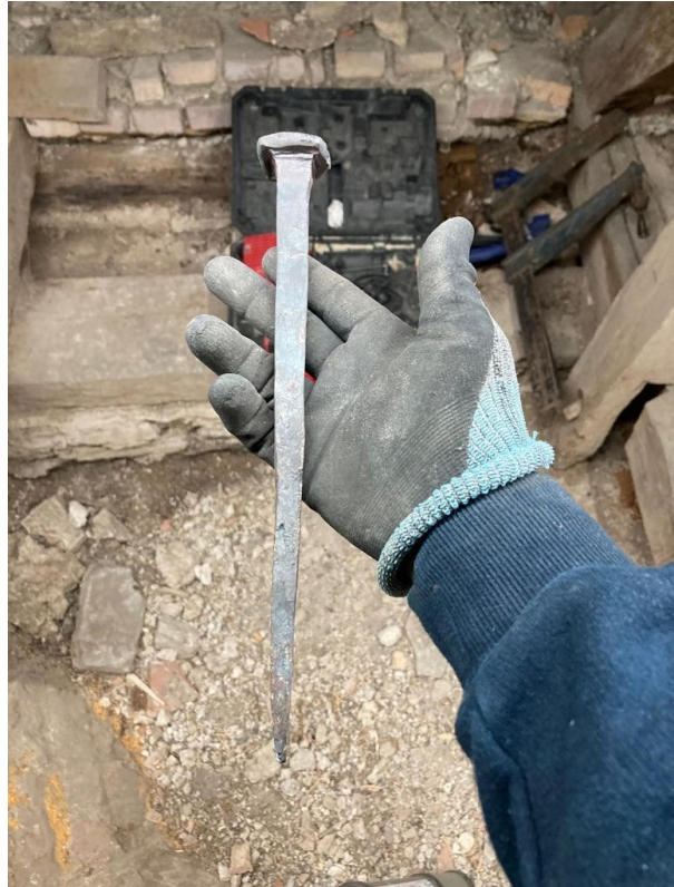
Nyttillverkad smidd spik efter befintlig förlaga.
