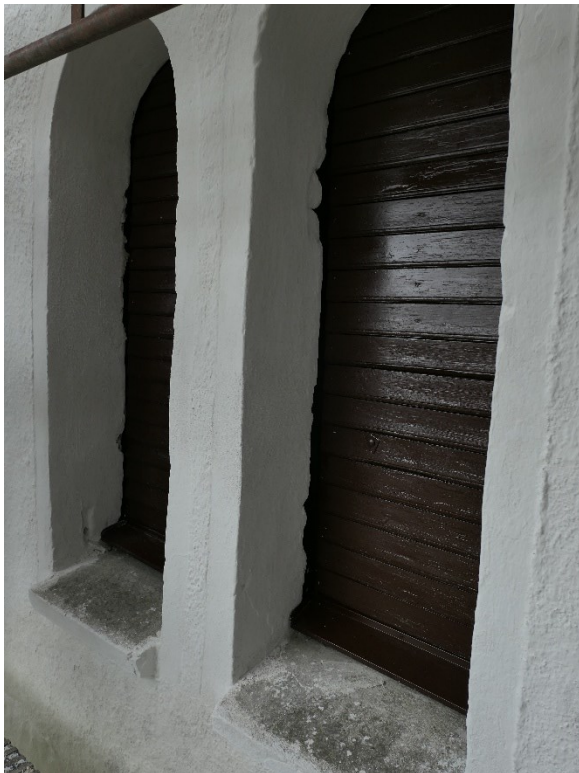
Efter åtgärder. Notera de nya plåtblecken nertill på luckorna. Vid fotograferingstillfället återstod att måla solbänkarna.
