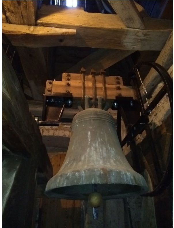
Vinkelaxel är monterad och ny kläpp.
