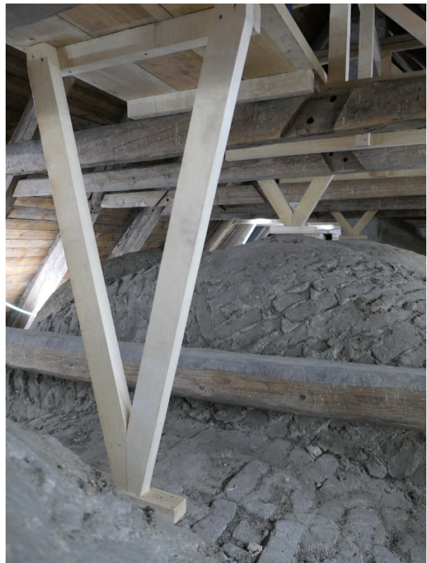
Trappa från tornet till långhusets spång. Spångens undre sida med stödben på "skida".
