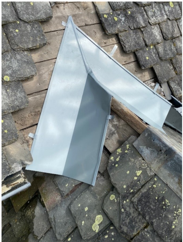
Partiell lagning skiffer samt nyanockplåtar på långhus och vapenhus. På bilden Kim Löschman, timmerman. Foto: Jens Ingvad.
