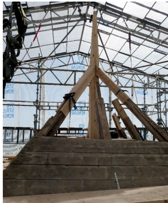
Spirstocken har tagits ner och sparrar kapas, på bilden Jens Ingvad. Ny spirstock och skarvade sparrar.
