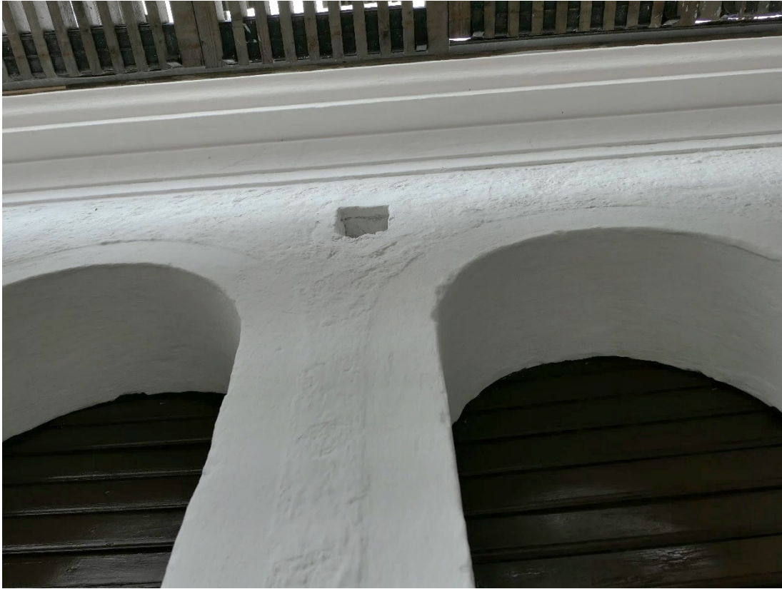
Efter åtgärder. På tornet finns gamla urtag där man sannolikt hängt "plattform" när man kalkat fasaderna.
