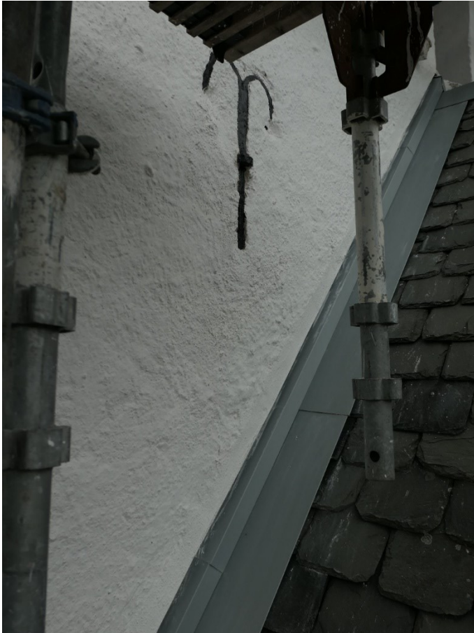
Efter åtgärder. Långhusets takmöte mot tornfasaden.
