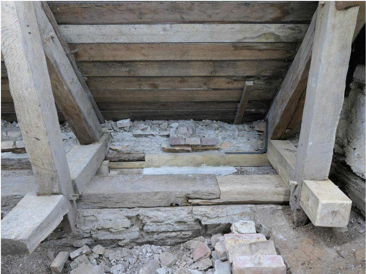
Före och efter åtgärder. Norra sidan vid östra gavelväggen, skadade lejder skarvades, en ny tass samt tegel som togs bort men sparas på vinden.
