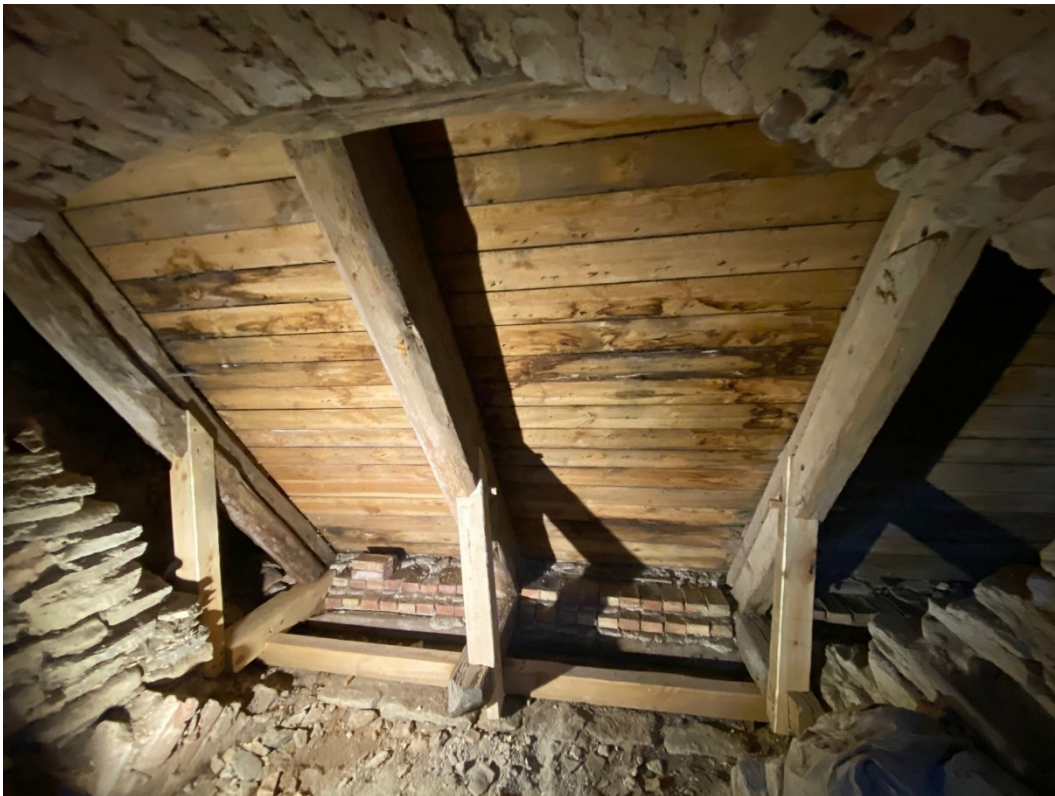
Takfallet i tornet mot norr. Före och efter åtgärder, lagningar stödben och lejd T1 N (längst till vänster i bild), T2 N (i mitten) och T3 N. Inre lejd ersatt i sin helhet. Tassens som ersatts finns längst till vänster i bild.
