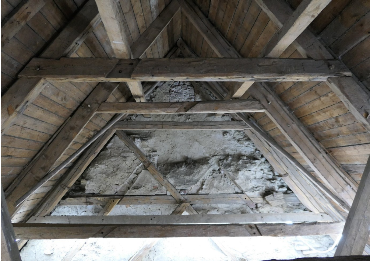
Efter åtgärder, östra gaveln med bevarad äldre del av takstol.
