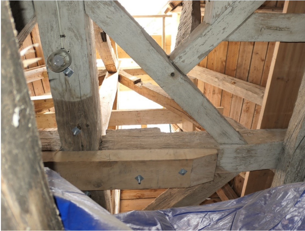
Efter åtgärder. Hjärtstock, spira och sparrar sett från klockvåningen. På bilden nedan ses den förstärkta hjärtstocken från ovansidan med spirstocken vertikalt i mitten.
