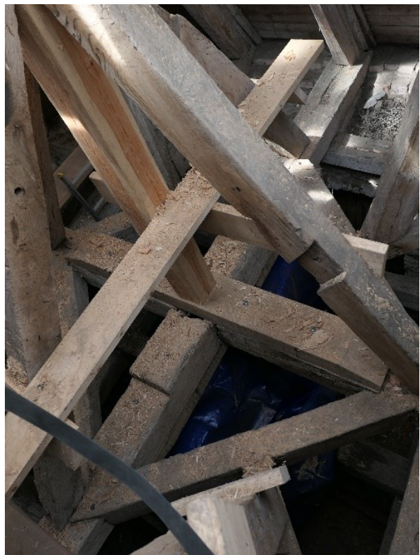
Under arbete. Nya hanband överst på vänstra bilden och ny hjärtstock på högra bilden. I mitten syns den vertikala nya spirstocken.
