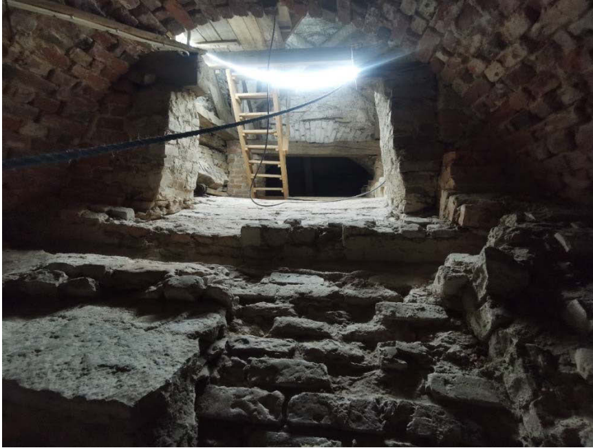
Figur 6. I kyrkans västra ände dokumenterades ett tunnvalv som tillhör kyrkans tidigare faser. Direkt på tunnvalvet har därefter kyrktornet byggts. Trappan på bild leder upp till klocktornet.
