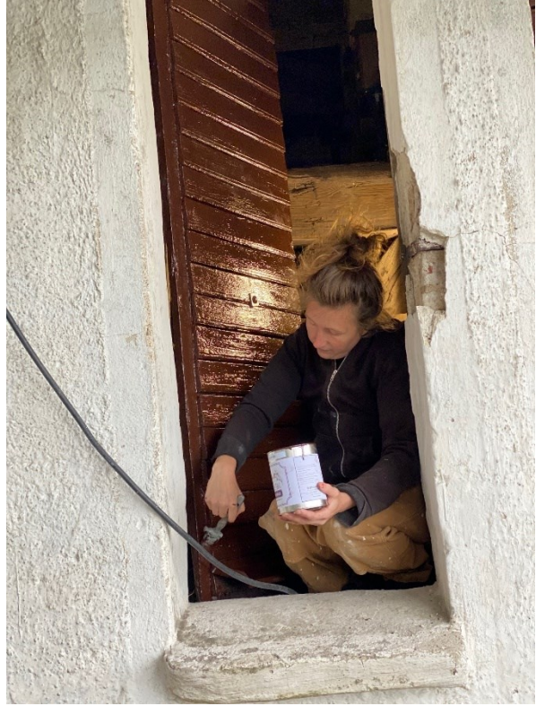
Efter åtgärder, ny stängning av luckor invändigt. Under arbete, luckorna målas. På bild Katja Robin, målare. Foto: Jens Ingvad.
