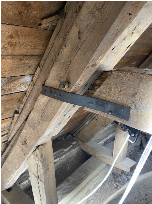
Exempel på förankring med smidd spik och dubb.
