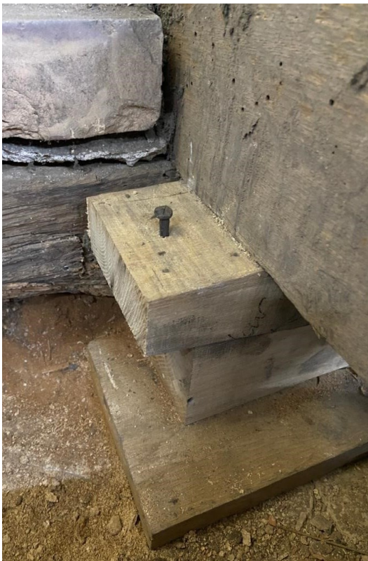
Skadat stödben som ersatts.
