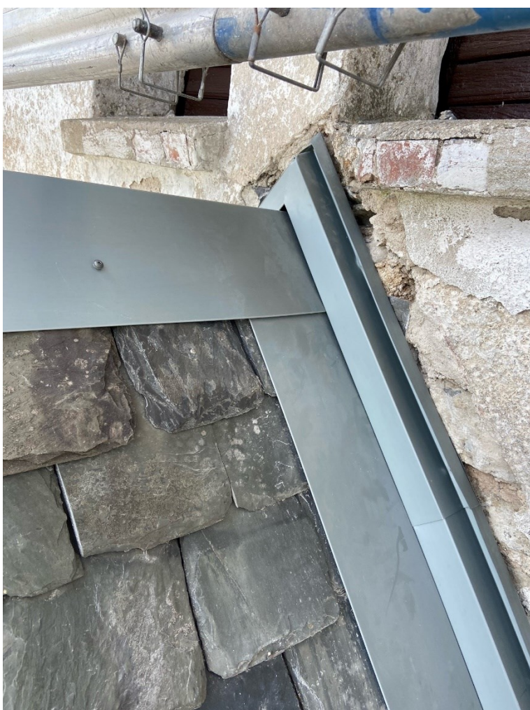
Lagning av plåttäckning. Vid fotograferingstillfället hade plåten målats i fel kulör, vilket rättades till senare.
