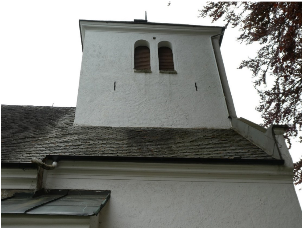
Före åtgärder. Tak och torn sett från norr.
