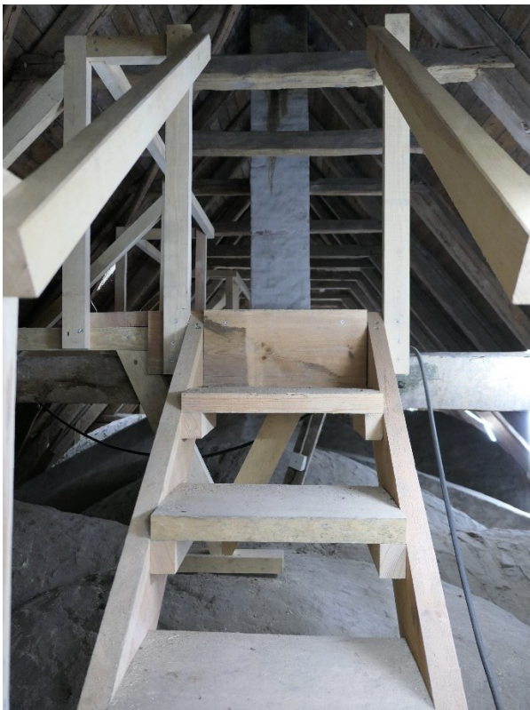
Efter åtgärder, östra gaveln med bevarad äldre del av takstol.
