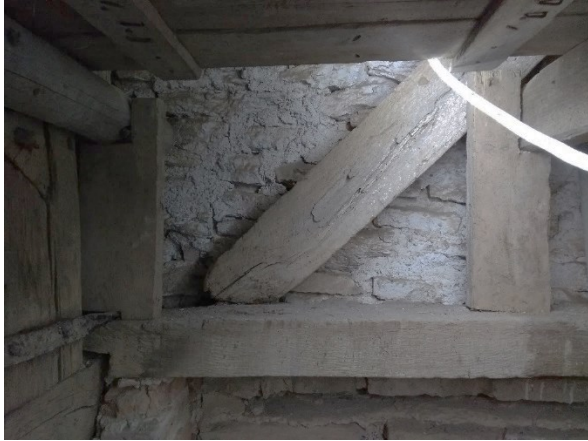
Före och efter åtgärder. Tornet snedsträva mot väster, ny ekplanka under stödben.
