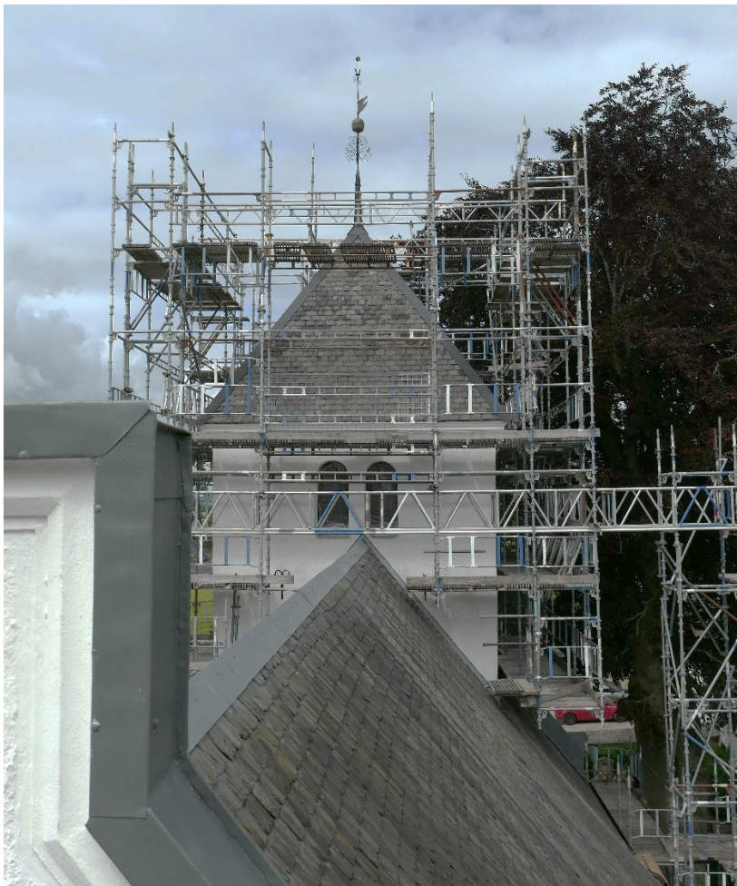
Efter åtgärder. Långhusets tak med vy mot tornet.
