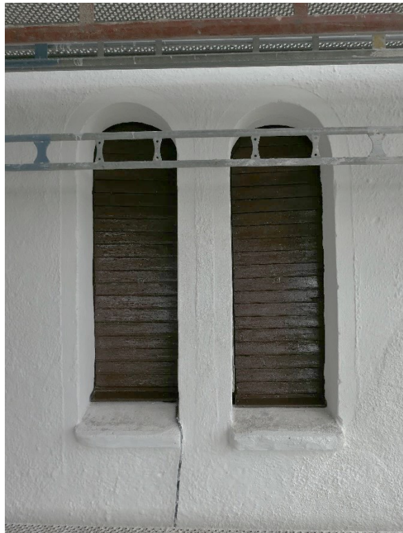
Efter åtgärder. Notera de nya plåtblecken nertill på luckorna. Vid fotograferingstillfället återstod att måla solbänkarna.
