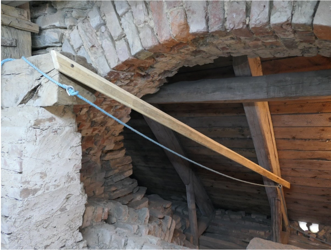
Ersatt handledare ovan spiraltrappan i tornet.
