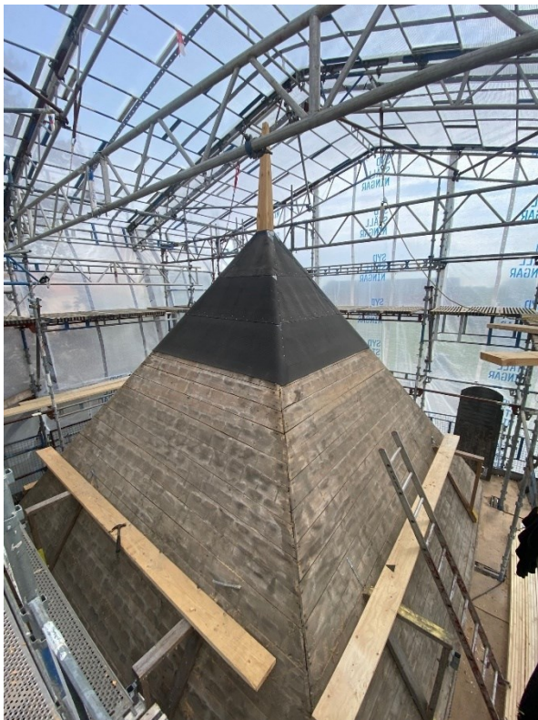
Papp läggs på torntaket. Höger: Spiran efter underhåll. På bilden Järnet i eldens hantverkare. Foto: Jens Ingvad.
