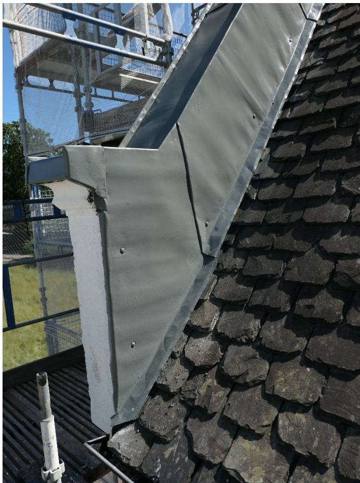
Efter åtgärder, mindre putskompletteringar återstod vid fotograferingstillfället.
