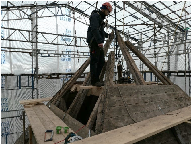
Spirstocken har tagits ner och sparrar kapas, på bilden Jens Ingvad. Ny spirstock och skarvade sparrar.
