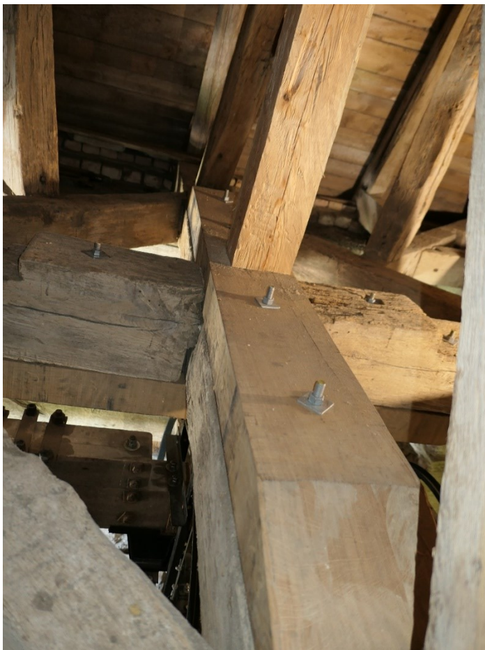
Efter åtgärder. Hjärtstock, spira och sparrar sett från klockvåningen. På bilden nedan ses den förstärkta hjärtstocken från ovansidan med spirstocken vertikalt i mitten.
