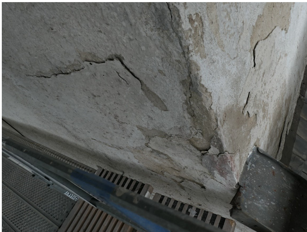
Före åtgärder. De största skadorna på tornet på sydvästfasaden.
