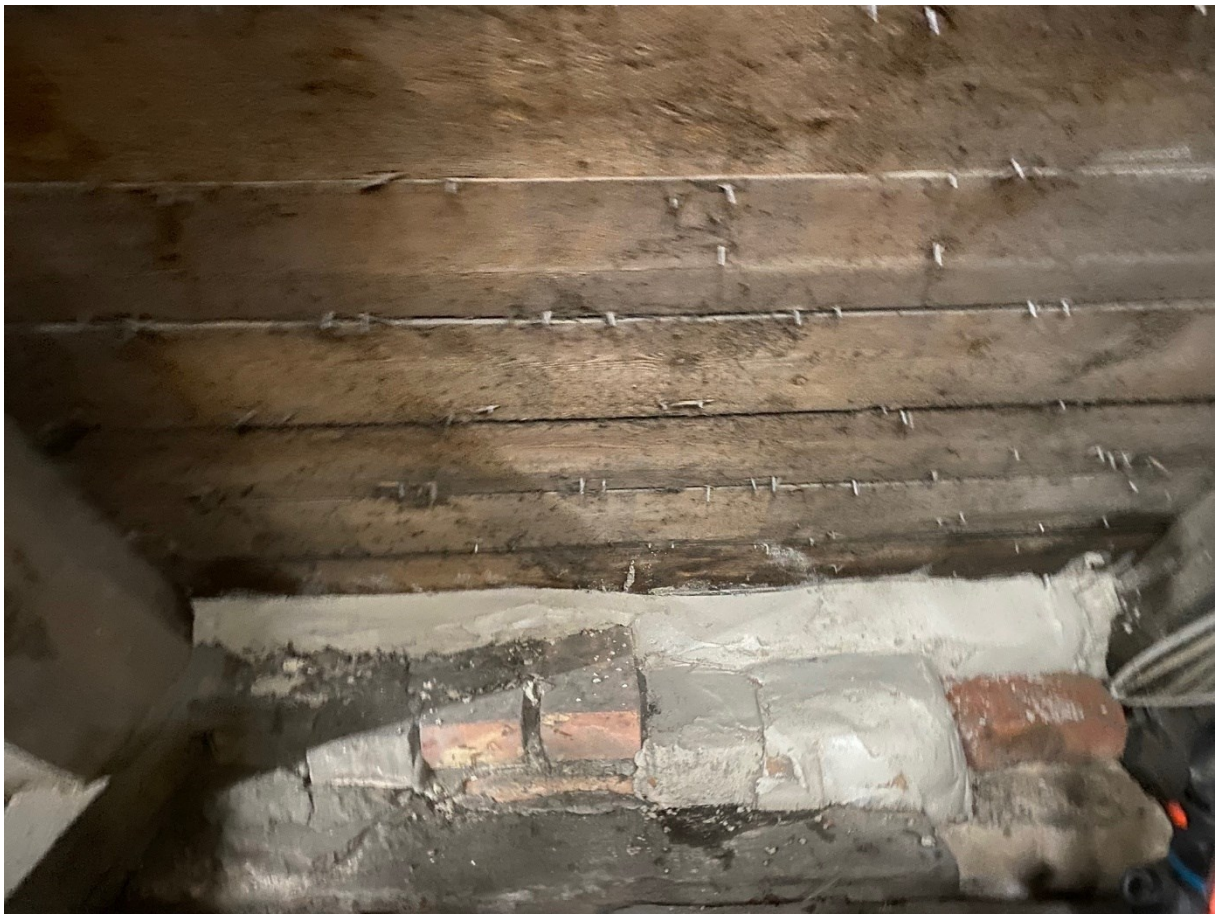
Före och efter åtgärder. Tornet snedsträva mot väster, ny ekplanka under stödben.
