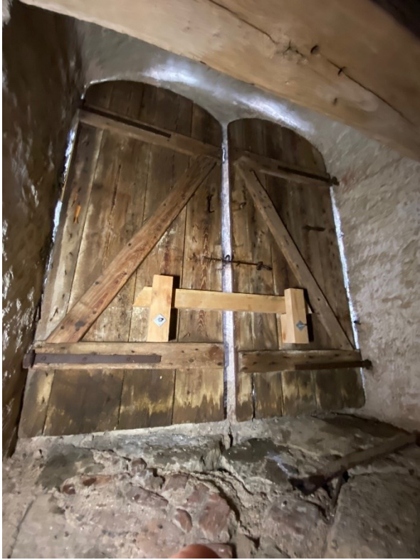
Efter åtgärder, ny stängning av luckor invändigt. Under arbete, luckorna målas. På bild Katja Robin, målare. Foto: Jens Ingvad.
