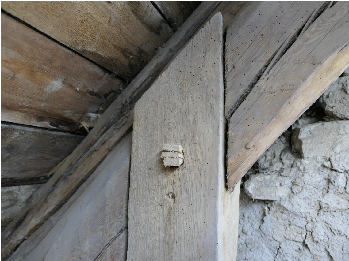
Efter åtgärder. Exempel på förankring med smidd spik och dubb med kil.
