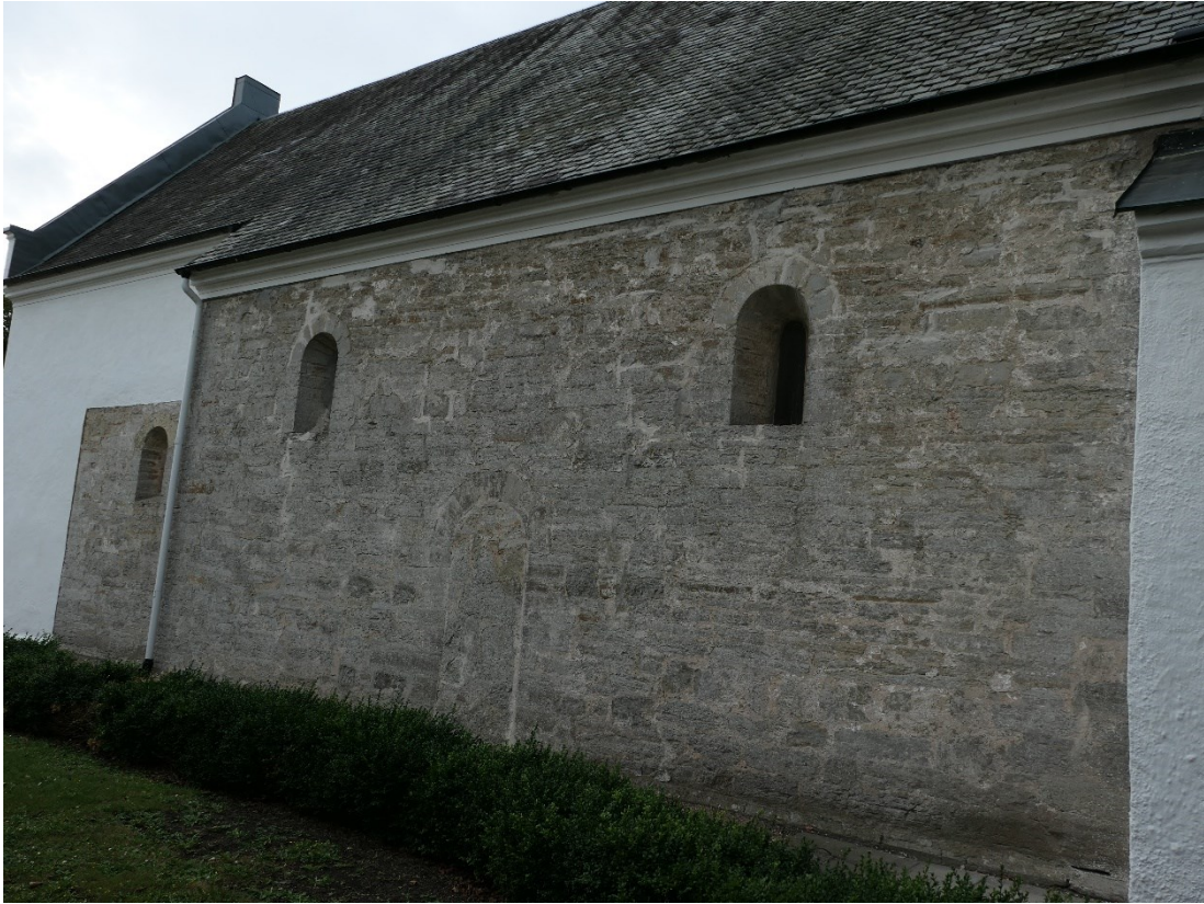
Efter åtgärder, lagningar på norra fasaden.
