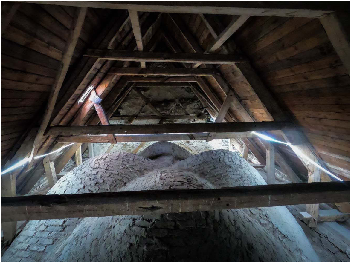
Foto taget från väst över travé 1 i östra änden av kyrkan. Valven över koret ses som fyra kullar. En travé är benämningen för en valvenhet. I Tostarps fall utgjordes en travé av fyra valv som på bilden ses som fyra kullar av tegel.
