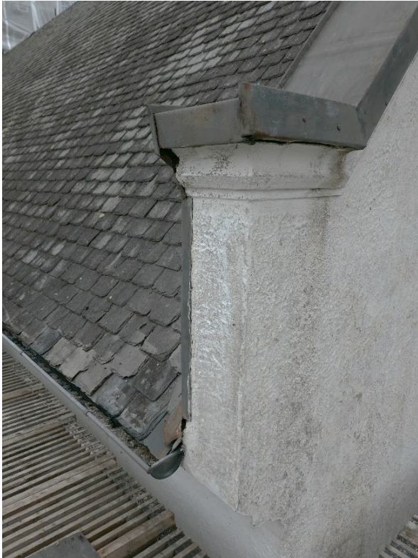
Före åtgärder. Exempel på plåtarbeten, puts och takskiffer.
