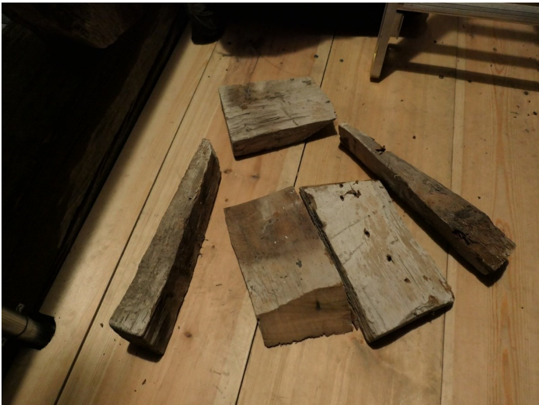
Nytt golv på klockvåningen och kilar som tagits bort mellan klockbock och murverk.
