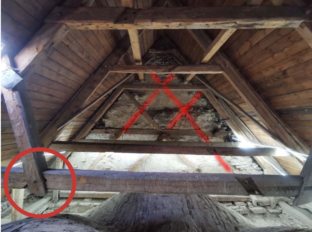
Figur 9. I muren på kyrkans östra kortsida dokumenterades spår av tidigare bjälkar som visar på den ursprungliga takhöjden. För att förtydliga har avtrycken efter bjälkar markerats med rött. Hanabandet i förgrunden är ytterligare ett exempel på återanvänt timmer. Vid hanabandets södra ände (till höger) finns en fog uthuggen. Stödbenet på hanabandets norra ände (till vänster) visar tydligt att vinkeln på fogen är fel. Inom den röda cirkeln går det även att se att en ny fog huggits ut över den äldre.
