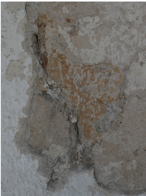
Under arbete. Östra gavelfasaden vid tidigare igenmurat fönster. Spår av gul färgsättning i anslutning till det igenmurade fönstret. Samt spår av grå färgsättning direkt invid det igenmurade fönstret. På bilden Patrik Sedin.
