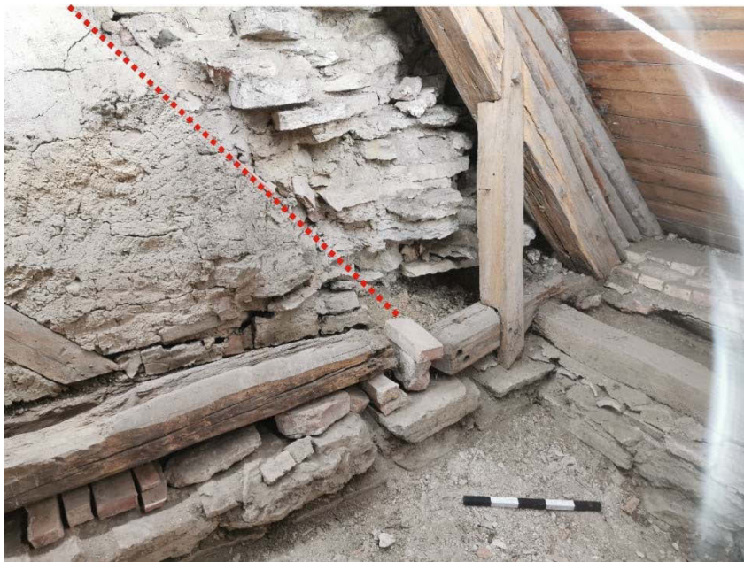
Figur 13. Fotot är taget från nordväst och visar övergången mellan områdena Ö1 och S1 i städat skick (jämför figur 15). Samma ände av remstycket syns på bilden ovan. Notera det sentida teglet som murats precis under taksponten. Den röda streckade linjen visar avtrycket efter en bjälke i taklaget. Till höger om den röda streckade linjen skiljer sig muren avsevärt, stenarna tycks murade utan ordning och saknar puts. Kanske rör det sig om en hastigt utförd lagning.
