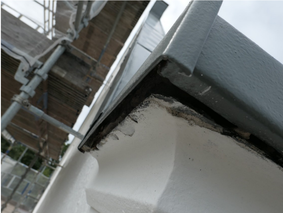
Under plåttäckningarna syns skiffer. Vid fotograferingstillfället återstår putskomplettering.
