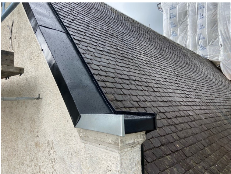
Lagning av plåttäckning. Vid fotograferingstillfället hade plåten målats i fel kulör, vilket rättades till senare.
