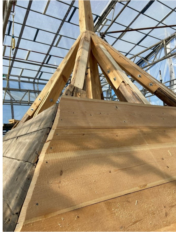
Skarvade sparrar och läggning ny underbrädning. Foto: Jens Ingvad.
