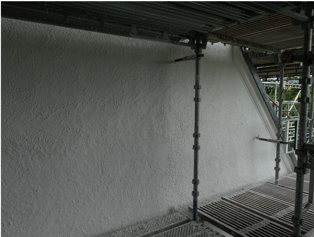
Efter åtgärder, västra tornfasaden.
