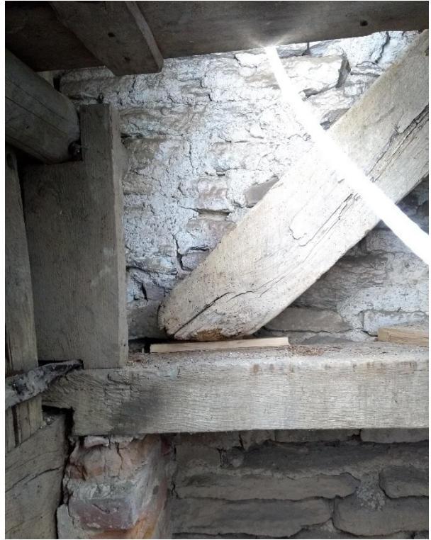
Före och efter åtgärder. Tornet snedsträva mot väster, ny ekplanka under stödben.
