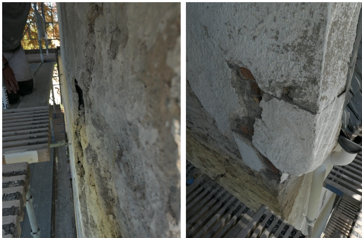
Före åtgärder. De största skadorna på tornet på sydvästfasaden.
