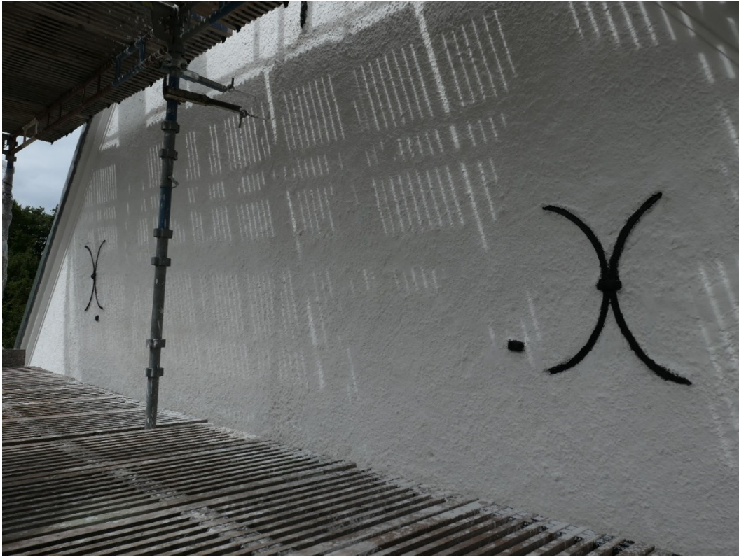
Efter åtgärder, östra fasaden och ankarjärn.
