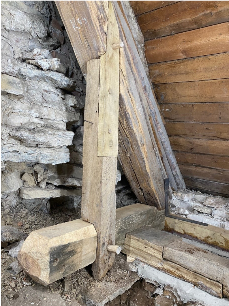
Efter åtgärder K5 S, tass, inre och yttre lejd. Tass bilad efter befintlig som förlaga.
