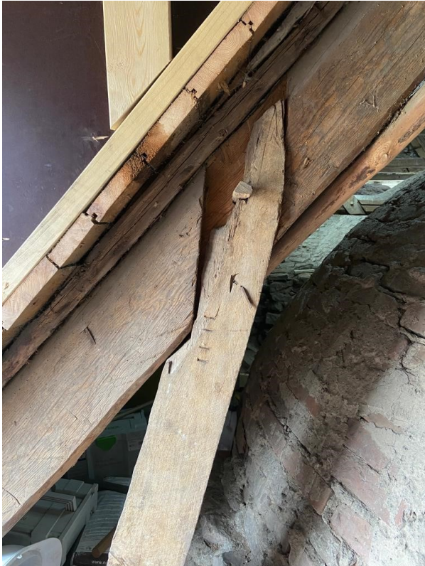
Skadat stödben som ersatts.
