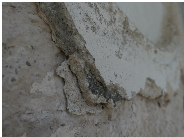
Under arbete. Östra gavelfasaden vid tidigare igenmurat fönster. Spår av gul färgsättning i anslutning till det igenmurade fönstret. Samt spår av grå färgsättning direkt invid det igenmurade fönstret. På bilden Patrik Sedin.
