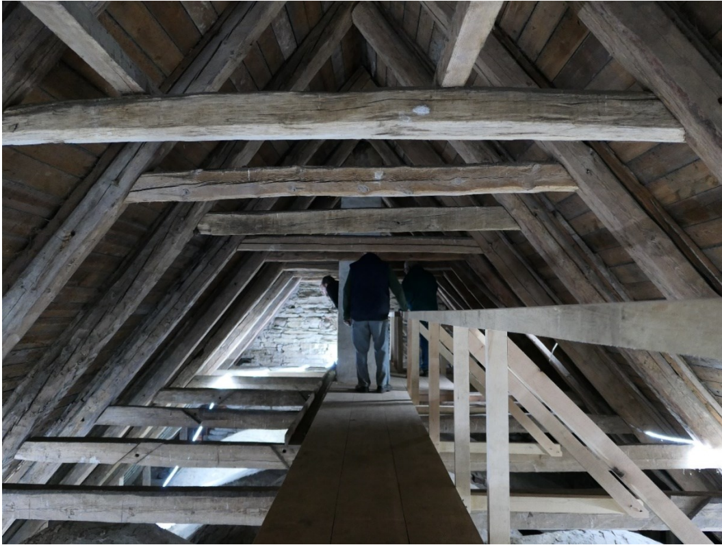
Långhusvinden vy mot väster efter åtgärder.
