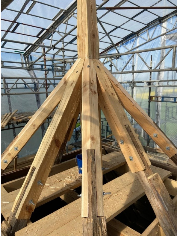
Skarvade sparrar och läggning ny underbrädning. Foto: Jens Ingvad.
