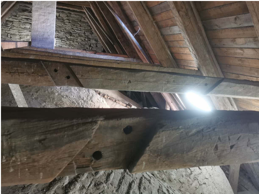
Figur 8. På vinden påträffades spår av återvänt timmer så som dessa hanaband. I hanabanden finns tydliga fogar uthuggna för stödben. På det bakre hanabandet sitter vinklarna för stödbenen fel, vilket tyder på att bjälken som utgör hanabandet återvänts och monterats upp och ner. På hanabanden finns markeringar i form av små trianglar som visat hantverkarna vilka bjälkar som hör ihop.
