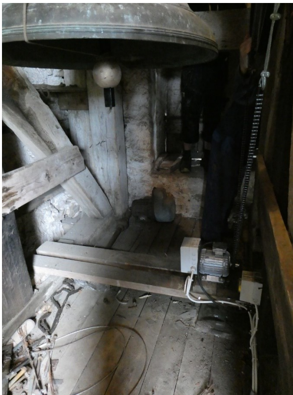
Nya motorer till klockringning, på bilden är ännu det gamla golvet kvar. Höger: Vinkelaxel är monterad och ny kläpp.
