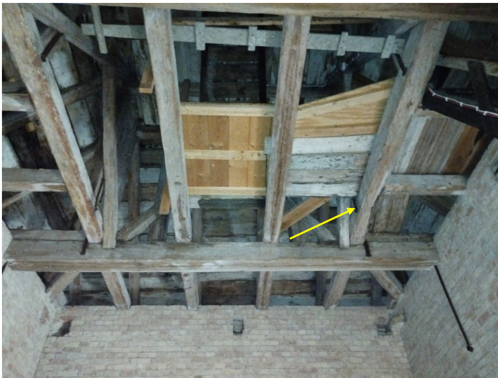
Före åtgärder. Aktuell tornbjälklag sett från klockvåningen, vy mot norr. Gul pil markerar den bjälke som förstärks.
