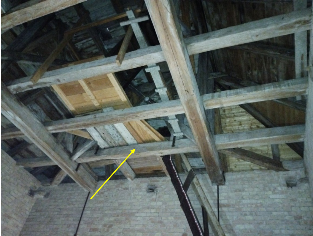
Före åtgärder. Aktuell vindbjälklag sett från klockvåningen. Gul pil markerar den bjälke som förstärks.
