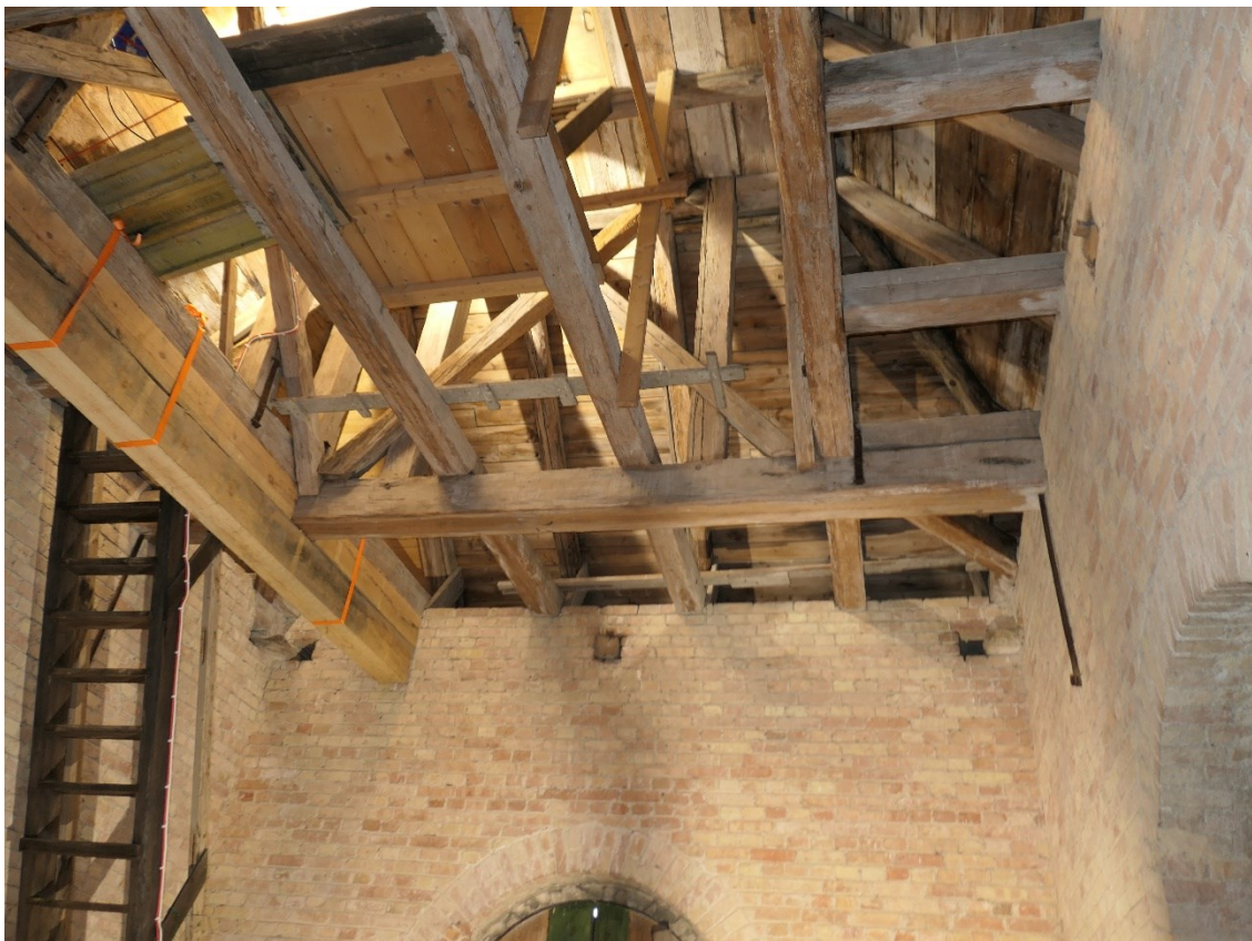
Under arbete med bjälken.
