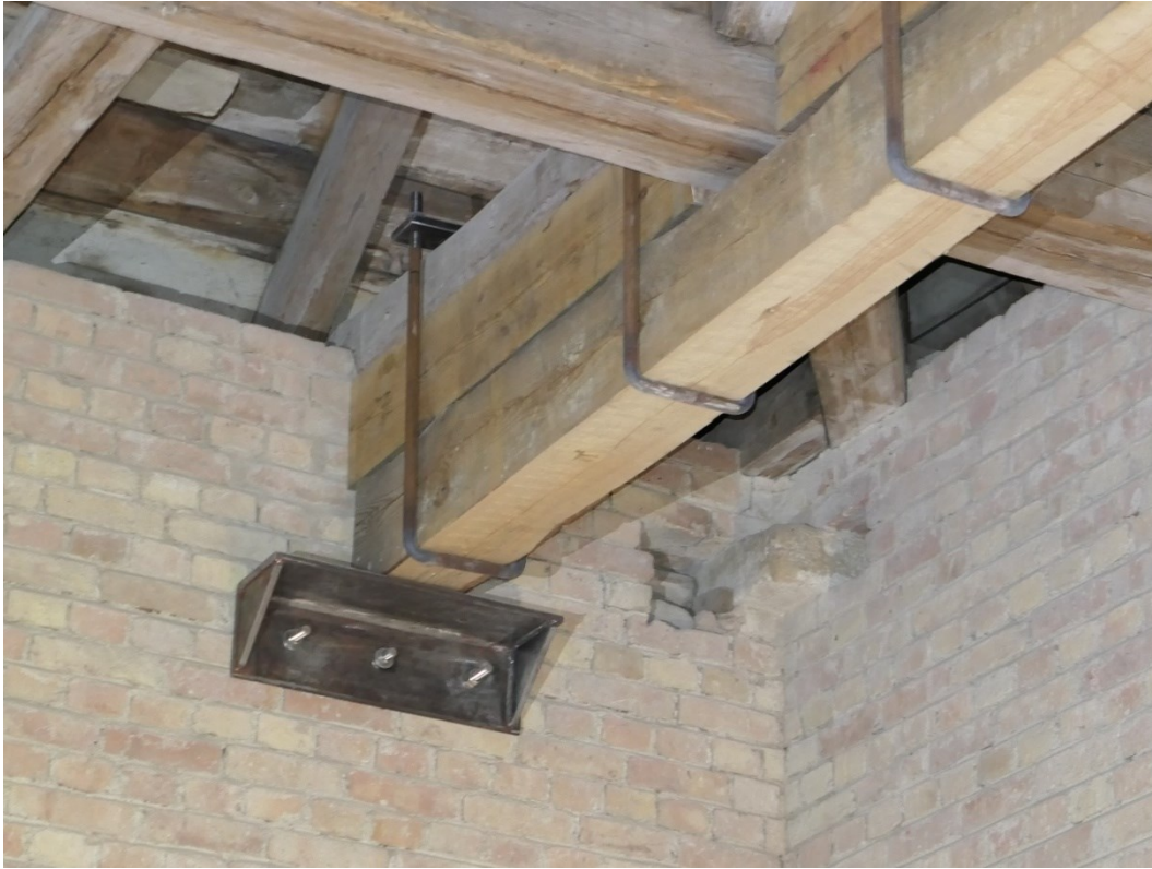
Efter åtgärder med bjälke.
