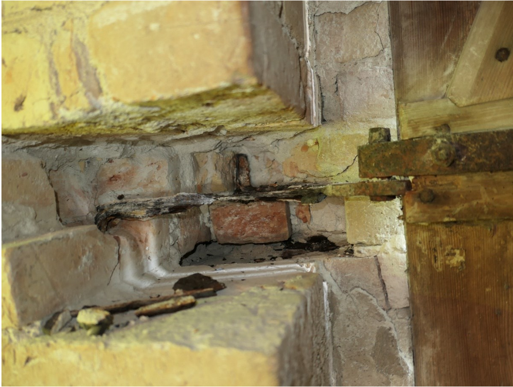
Under arbete, de inmurade gångjärnshakarna tas bort.
