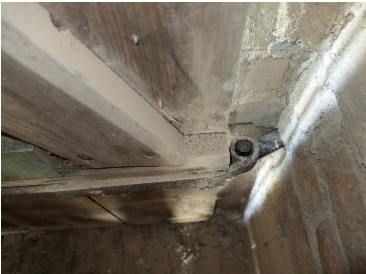
Efter åtgärder. Exempel på nya inmurade gångjärnshakar.
