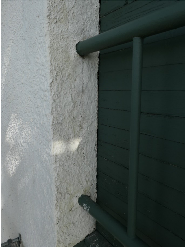
Vänster: före åtgärder. Sprickbildning vid utvändigt räcke vid västra luckan. Höger: efter åtgärder. Vid fotograferingstillfället återstod att måla träpanelen.
