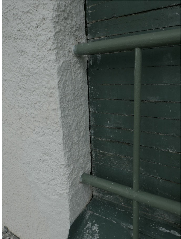
Vänster: före åtgärder. Sprickbildning vid utvändigt räcke vid västra luckan. Höger: efter åtgärder. Vid fotograferingstillfället återstod att måla träpanelen.
