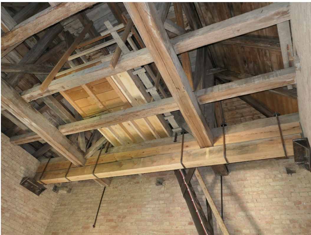
Efter åtgärder, samma vy som före åtgärderna. Nya bjälkar är kramlade samt vilar på konsoler fästa i muren.
