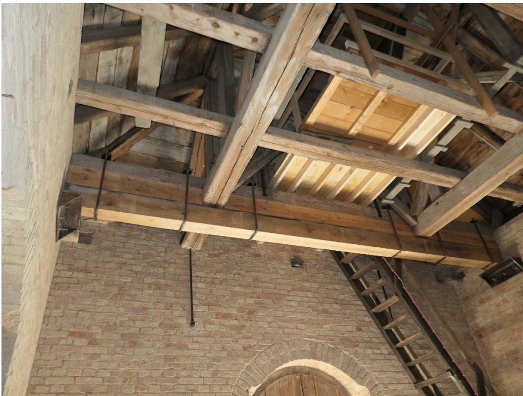
Efter åtgärder med bjälke och förstärkt plattform.
