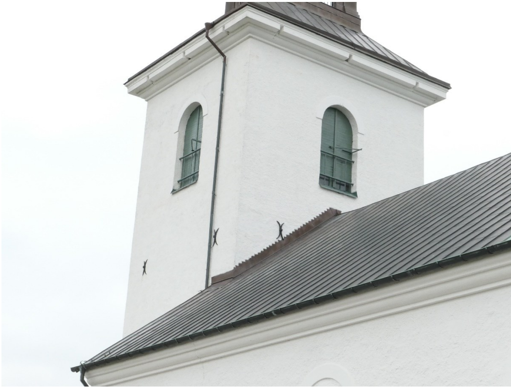
Efter åtgärder. Södra och östra ljudluckorna.
