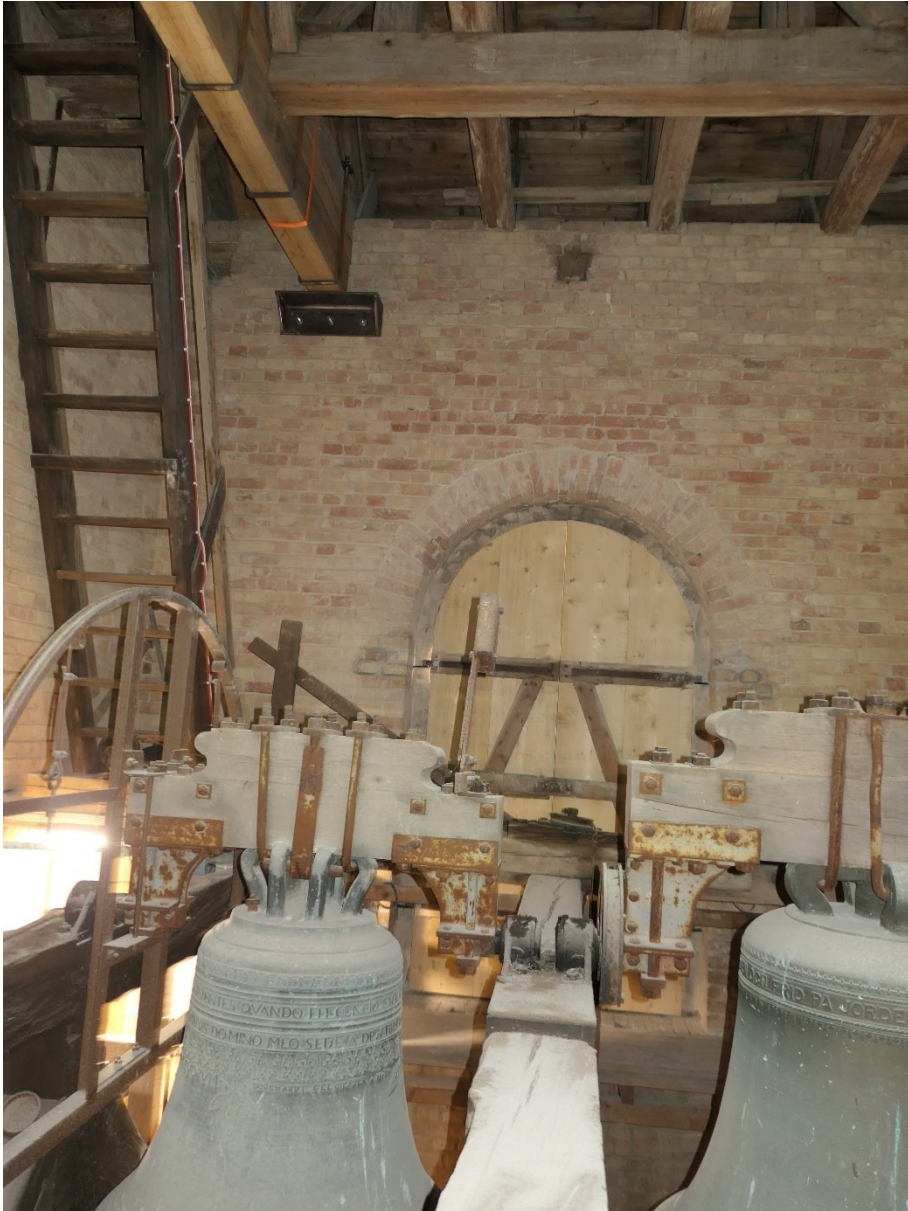
Efter åtgärder. Den nya bjälken och södra ljudluckan.
