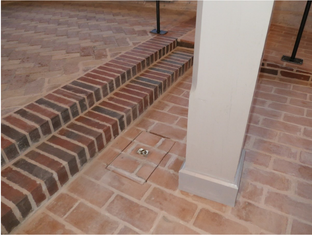
Trappan till estraden, eldosa dold i golv, sockellist till pelare.
