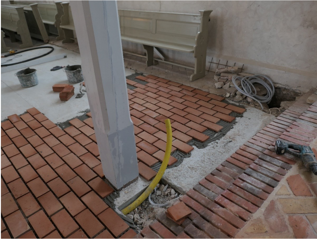
Tegelgolv läggs och trappan till estraden byggs upp. Invid väggen syns genomföring för avfuktarens dränage.
