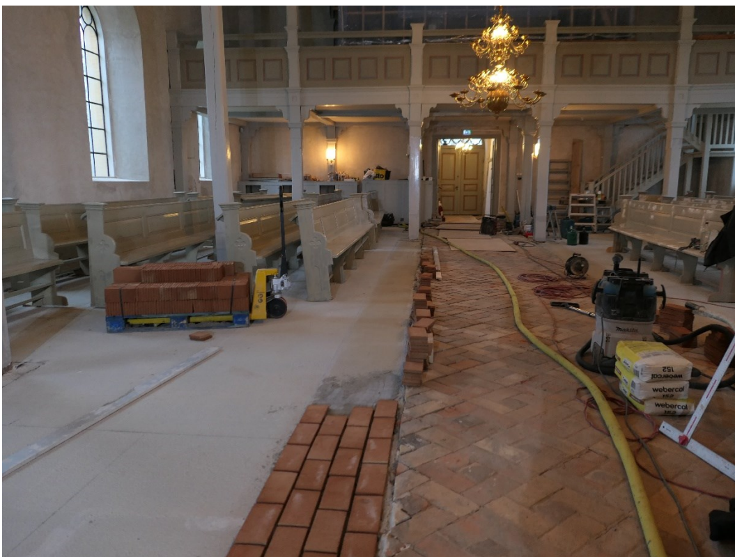
Det nya tegelgolvet har börjat läggas i bänkkvarteren.
