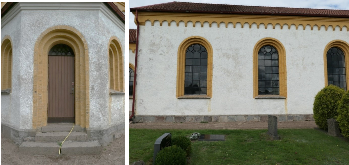
Dörren i absiden och kyrkans norra fasad.
