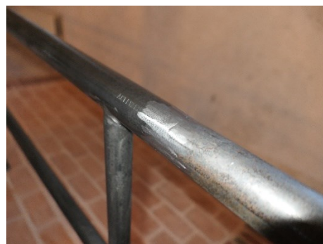
Den nya rampen. Detalj av räcke där det svetsats innan det målades.
