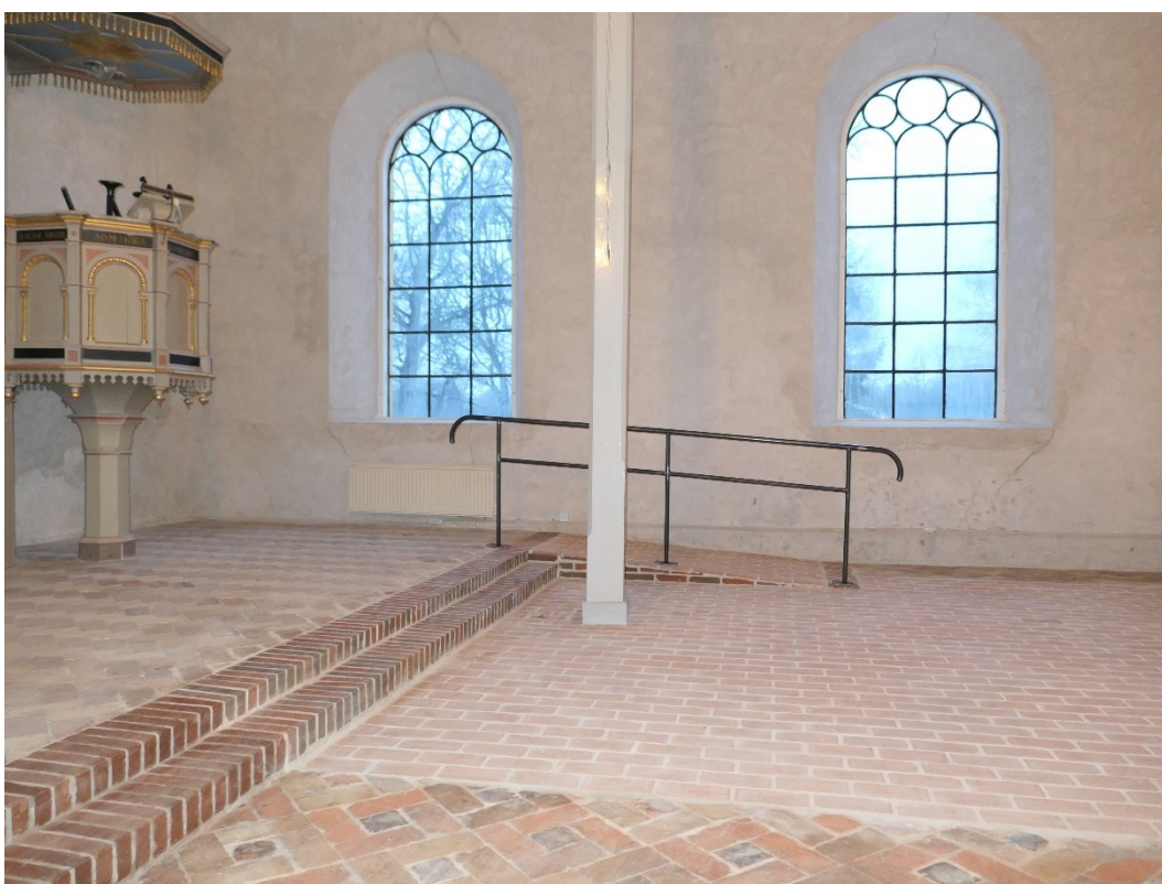
Rampen vid norra sidan av långhuset, trappan längs estraden är förlängd.
