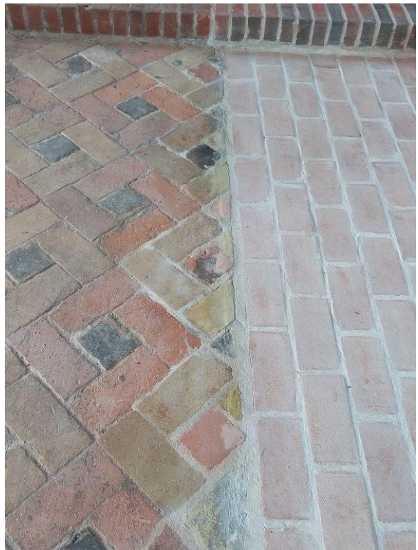
Imitation av det mönstermurade golvtegllet, yta i nordväst
