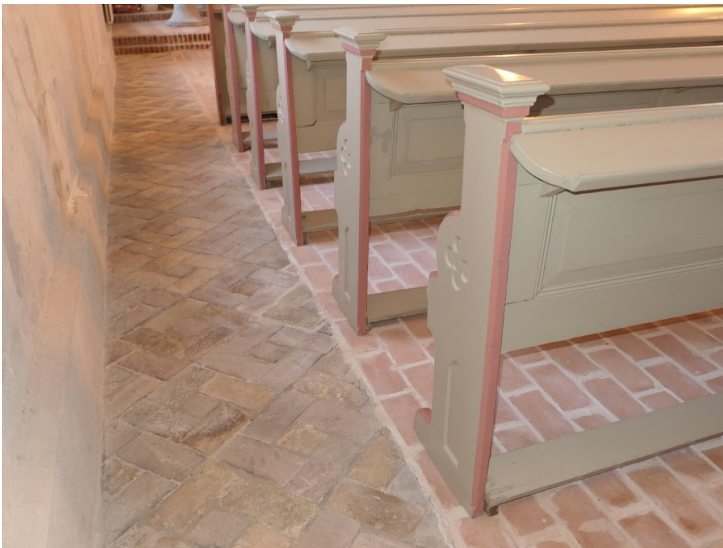
Befintligt tegelgolv i sidogången och nytt tegelgolv i bänkraden. På bilden södra sidogången. De tidigare vägghängda radiatorerna är nedmonterade.
