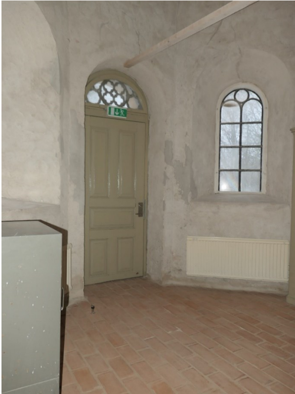
Sakristian. Nytt tegelgolv, målad inne0-r och ytterdörr. Ny dörrstopp i tegelgolvet. Kassa skåpet skymtas till vänster i bild. Radiatorer har behållits.
