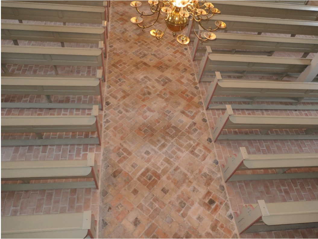
Nytt golv i bänkraderna och bevarat golv i mittgången.
