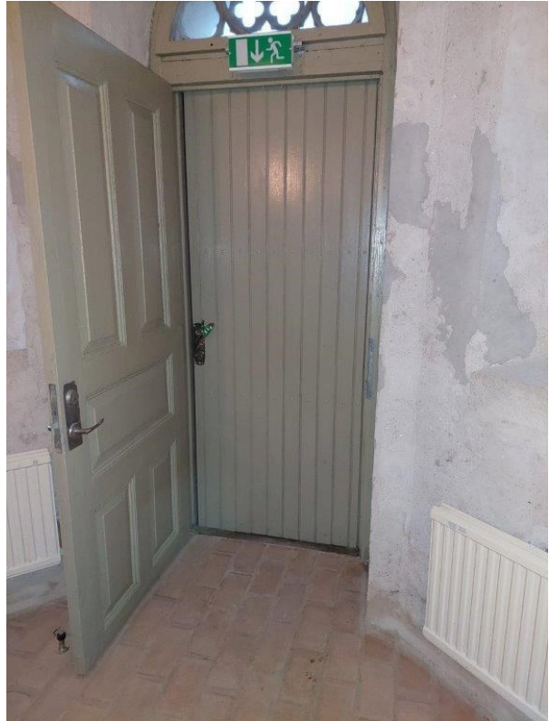
Sakristian. Nytt tegelgolv, målad inne0-r och ytterdörr. Ny dörrstopp i tegelgolvet. Kassa skåpet skymtas till vänster i bild. Radiatorer har behållits.
