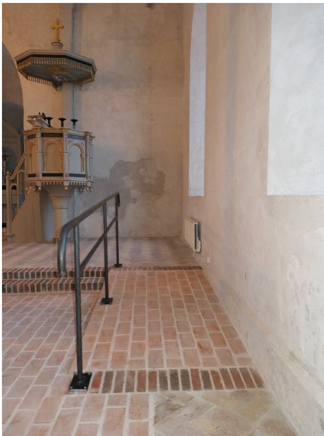
Den nya rampen. Detalj av räcke där det svetsats innan det målades.
