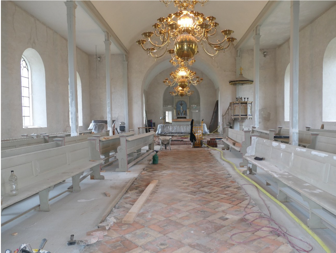
Betong är gjuten i bänkkvarteren och målningsarbete med bänkarna har påbörjats.
