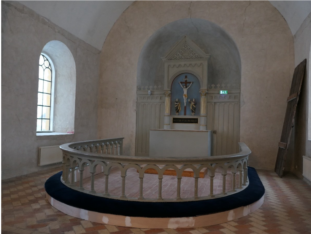
Altarring och nytt tegelgolv innanför denna. Vid fotograferingstillfället återstod att måla altarringens fundament.
