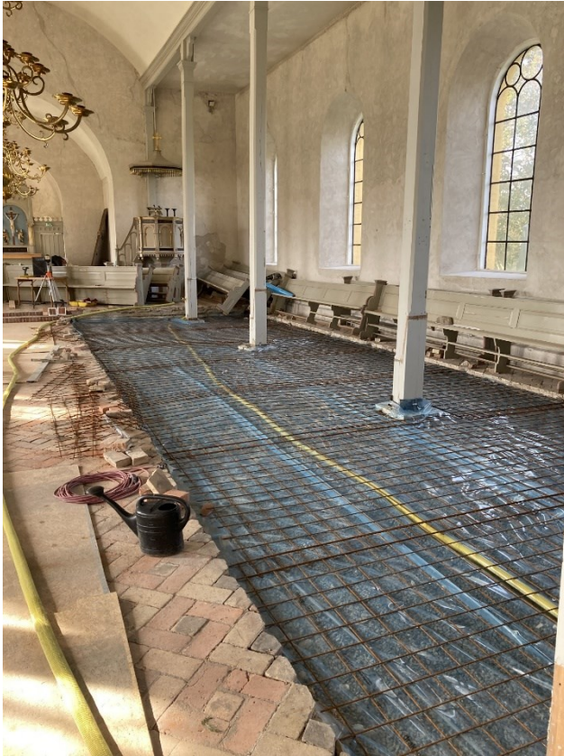
Utjämning med makadam, plastfolie och armering, inför gjutning. Foto: Anders Burman.
