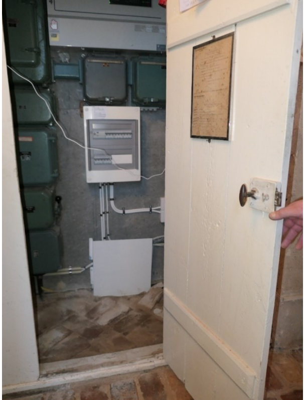
Sakristian. Nytt tegelgolv, målad inne0-r och ytterdörr. Ny dörrstopp i tegelgolvet. Kassa skåpet skymtas till vänster i bild. Radiatorer har behållits.
