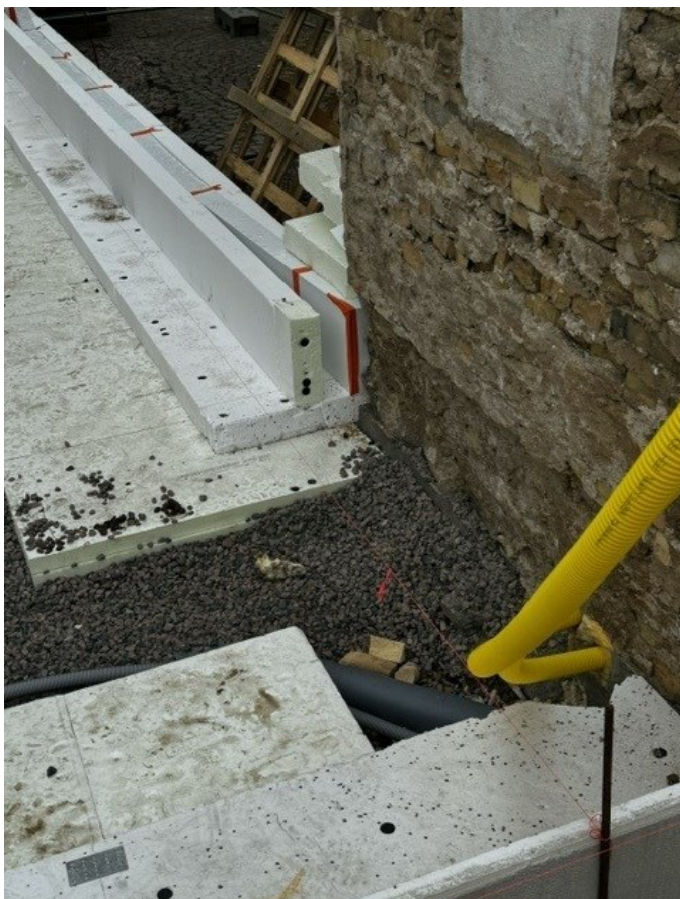
Figur 13. Ledningsdragningar lades på gruset och anslutning skedde till befintlig byggnad. Fotografi taget från nordost.
