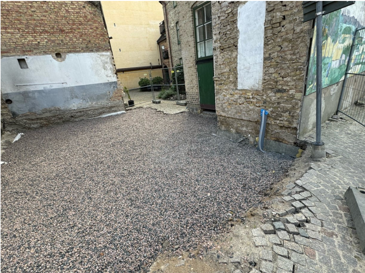
Figur 11. Ytan med geotextilduk täcktes därefter med grus. Fotografi taget från nordost.
