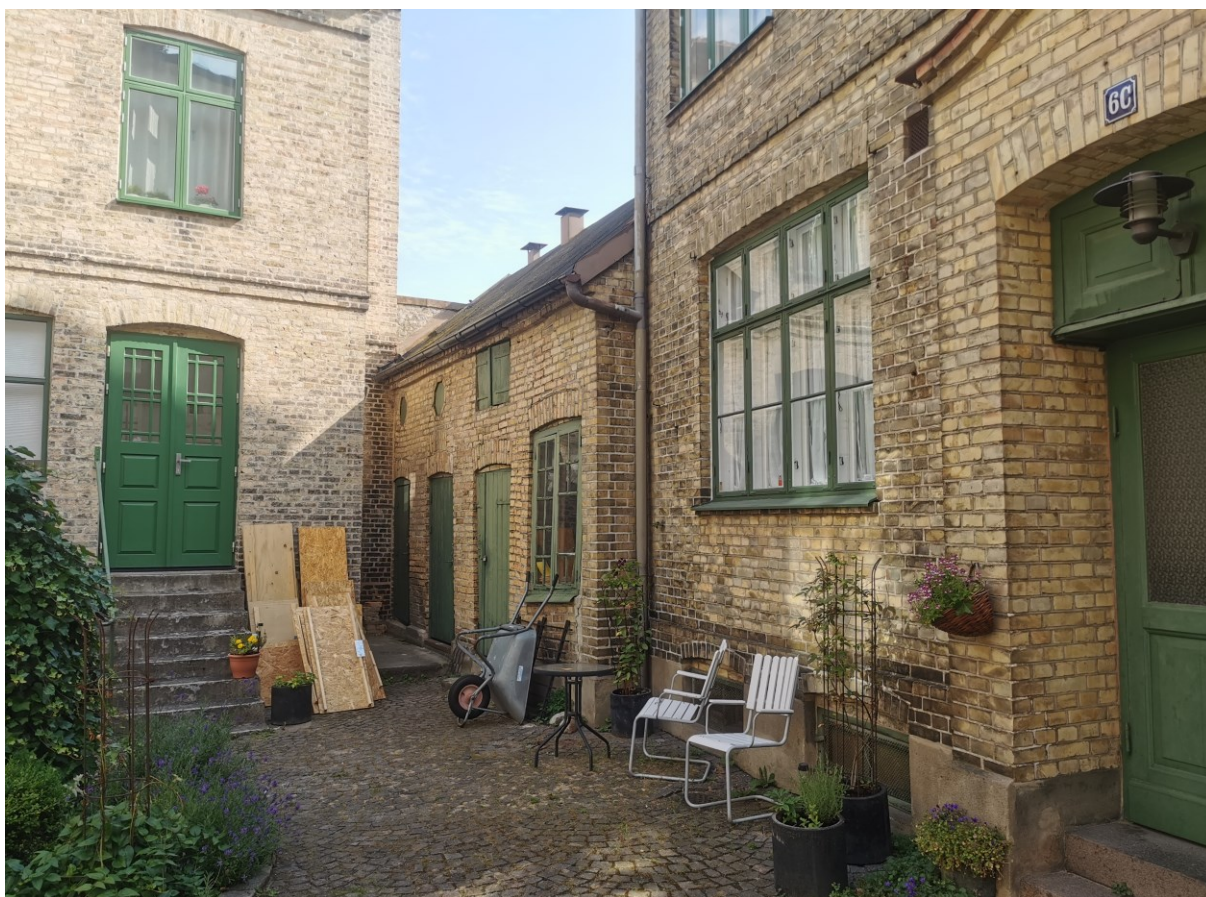
Figur 2. Fastigheten har en bevarad bakgårdsmiljö, med få förändringar under 1900-talet. Den låga byggnaden på bilden revs inför aktuell undersökning. Byggnaden uppfördes i början av 1900-talet. Fotografi taget från söder.
