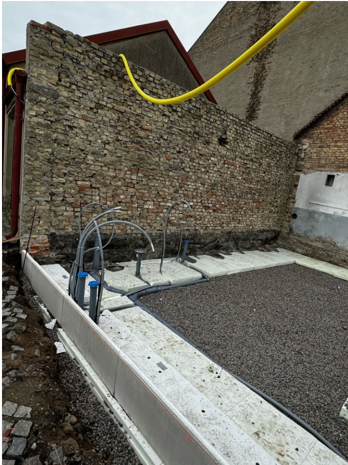
Figur 12. Ledningsdragningar lades på gruset. Fotografi taget från nordväst.
