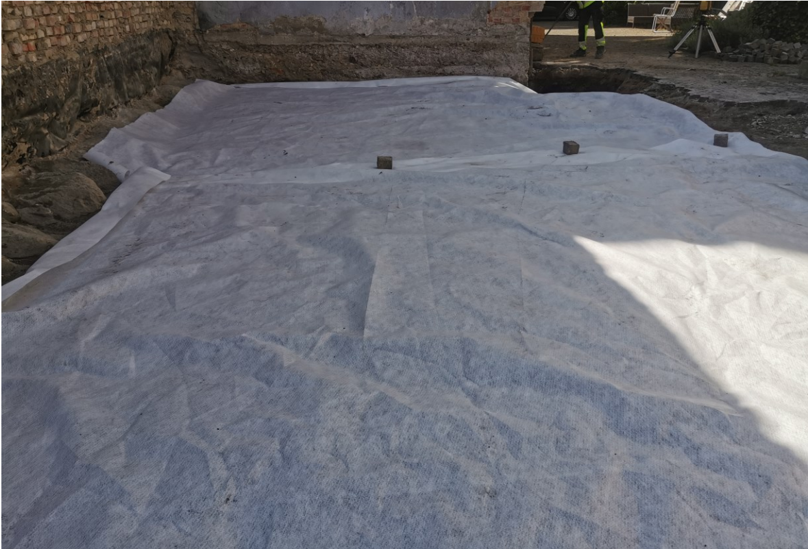
Figur 10. Den schaktade ytan täcktes med geotextilduk. Fotografi taget från norr.
