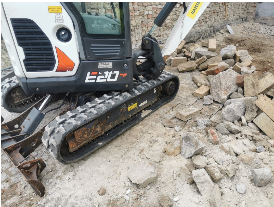
Figur 7. Grävmaskin stående på ett tegelgolv. Fotografiet taget från nordväst.
