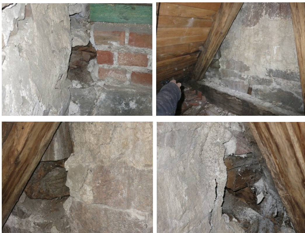
Figur 37. I murverket mellan absiden och koret finns delar av ett äldre remstycke/murlejd kvar från en äldre takstolskonstruktion. Foto 2017 ©Kulturen.
