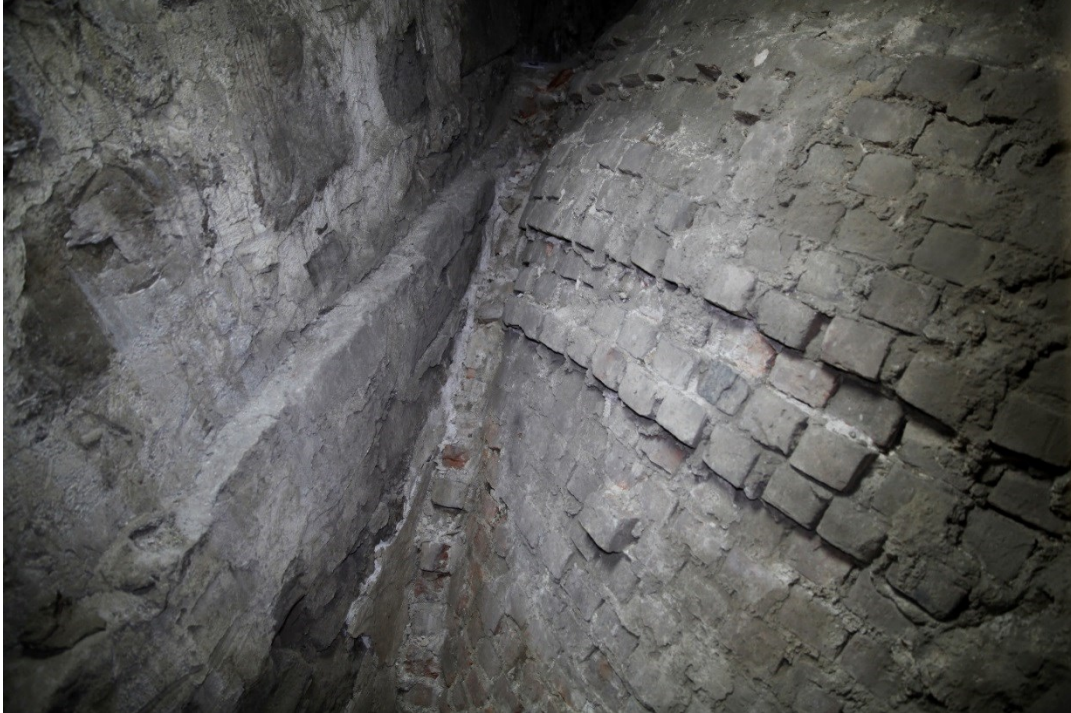
Figur 61. Valven i långhuset har på ovansidan utstickande tegelstenar, ibland i hela rader och ibland enskilda stenar. Foto 2017 ©Camilla Melin, Knadriks Kulturbygg.
