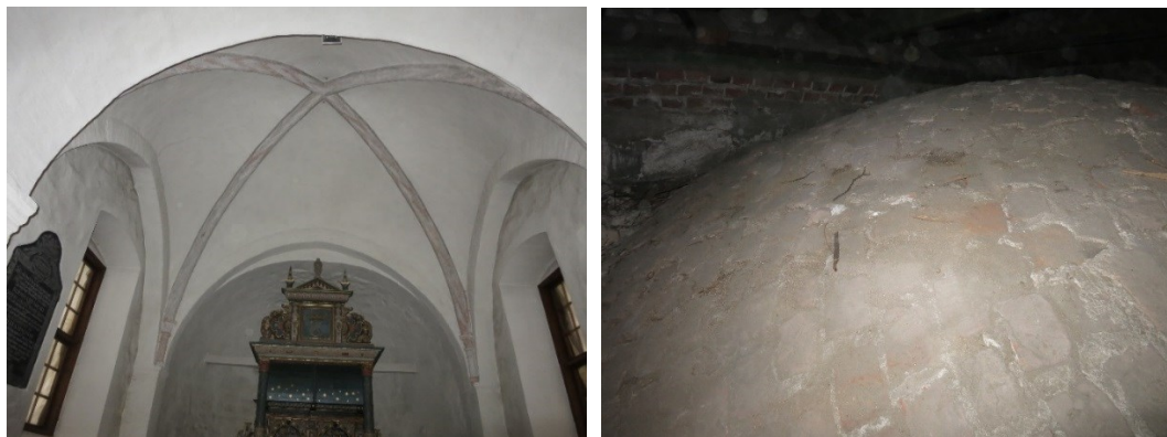
Figur 55. Till vänster. Valvet över koret, underifrån sett. Till höger. Valvet över koret, från ovasidan på vinden. Foto 2017 ©Kulturen.
