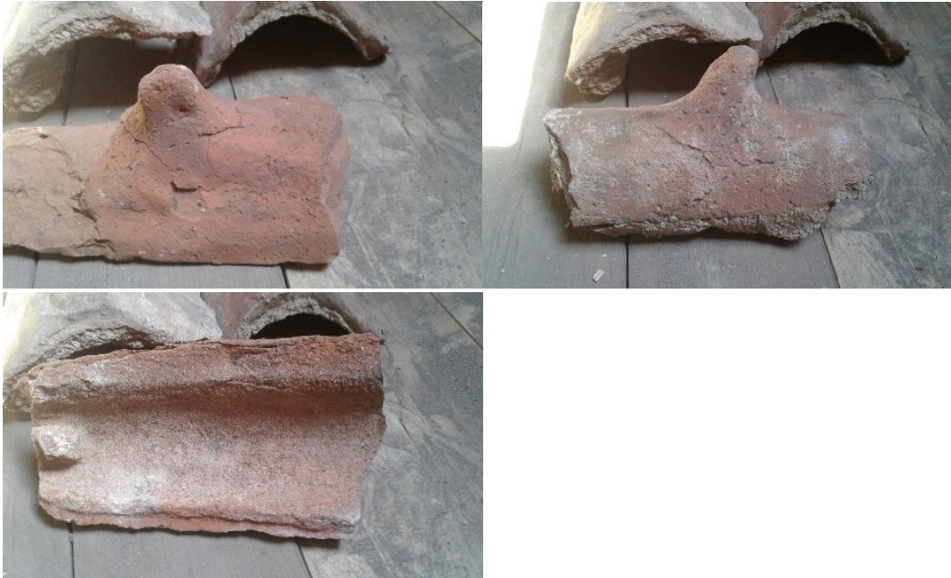
Figur 18. Munktegel, den undre bilden visar undersidan av ett munktegel med en liten hake som inte alltid finns men som bidragit till att hålla fast munkteglet mot det underliggande nunneteglet. Foto 2017 ©Kulturen.
