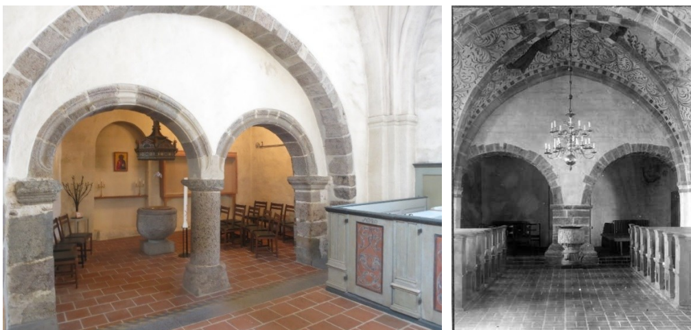
Figur 53. Till vänster. Fjälkinge kyrkas tornrum i bottenvåningen har försetts med en påkostad inramning och öppning in mot långhuset. Foto ©Kulturen. Till höger. En liknande lösning finns i Östra Hoby kyrka. Foto av Monica Rydbeck, Riksantikvarieämbetet. Public domain.
