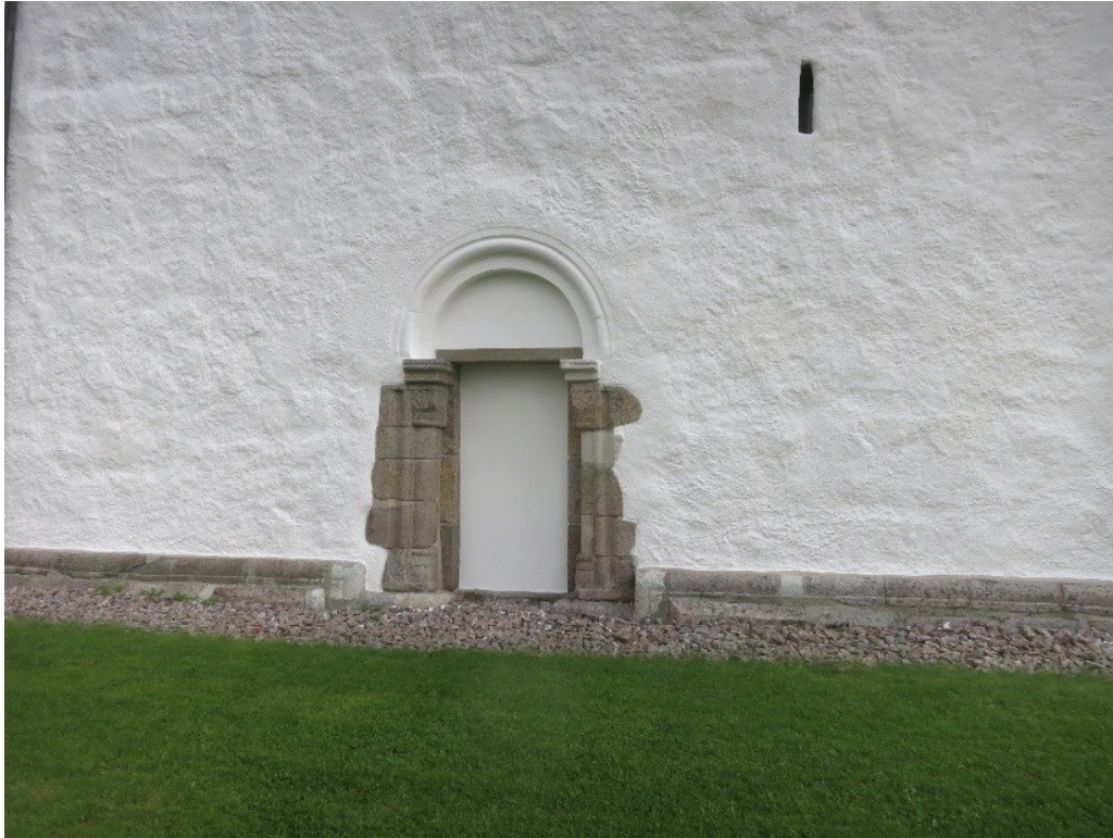
Figur 68. Portalomfattning i tornet tillägnad Carl stenmästare. Foto 2017 ©Kulturen.
