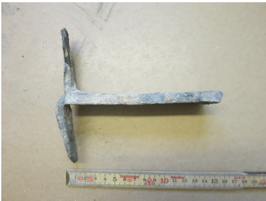
Figur 21. Ett dragjärn påträffades som bestod av ett plattjärn som i ena änden delats i två delar som vikts ut åt sidorna. Foto 2017 ©Kulturen.
