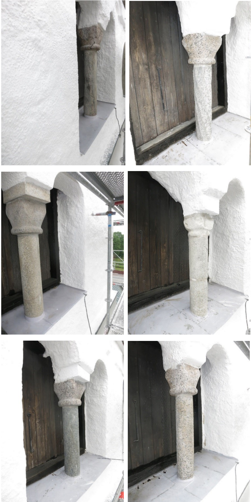
Figur 73. Det finns också kolonnetter i klockvåningens ljudöppningar i tornets övre våning. De är utförda i materialet granit/gnejs, förutom en i sandsten. Baserna är borttagna. Foto 2017 ©Kulturen.
