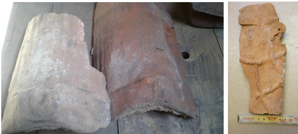
Figur 17. Nunnetegel med en tapp som hållit fast teglet mot läkten. Bilden till höger visar ett nunnetegel som har försetts med ett mönster med pålagd lera. I den högra sidan har nunneteglet ett inhak där man kunnat fästa teglet mot läkten med spik. Dekoren är ovanlig och man kan fundera över om det varit en avsiktlig del av produktionen av taktegel. Foto 2017 ©Kulturen.
