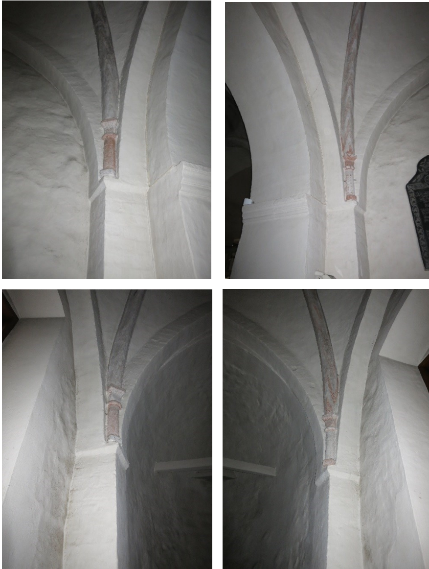
Figur 72. Kolonnetter finns i koret och fungerar som konsoler som valvets bågar vilar på. Det är svårt att avgöra vilket material de är utförda i utan att komma nära dem, då de är målade. Foto 2017 ©Kulturen.
