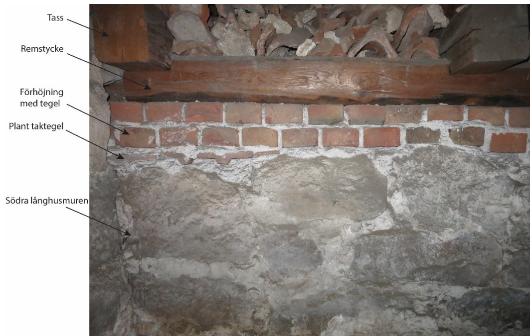
Figur 40. I samband med att takfallet ändrats har murkrönet höjts. Ungefär två skift med tegel har murats upp. På bilden kan man också se att som utjämning mellan det äldre murkrönet och det första tegelskiftet har använt plant taktegel som utjämning. Foto 2017 ©Kulturen.
