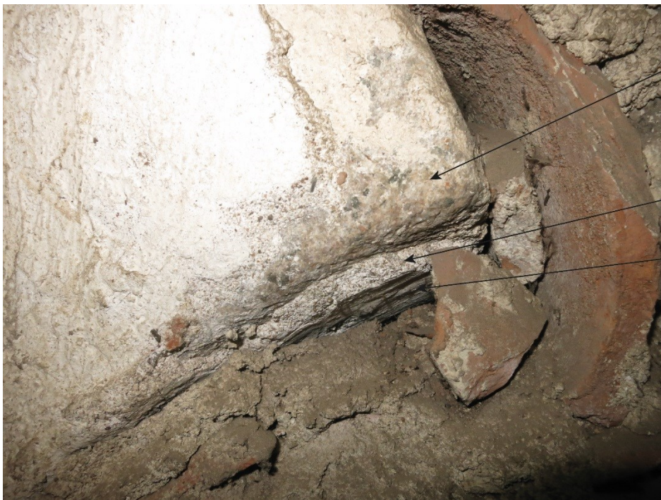
Figur 44. Detaljbild av den medeltida fönsteromfattningen. I omfattningen finns bevarad puts och avputsningsskikt. Foto 2017 ©Kulturen.
