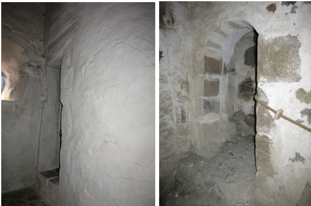
Figur 69. Till vänster. Portalomfattning i tornets bottenvåning. Till höger. Portal i tornets andra våning, där bågen har blivit lagad vid något tillfälle. Foto 2017 ©Kulturen.
