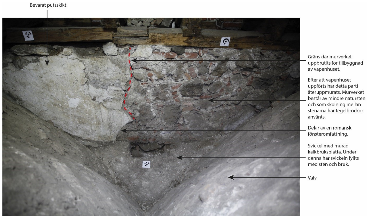
Figur 41. I södra långhusväggen finns delar av ett bevarad romansk fönsteromfattning. Foto ©Camilla Melin, Knadriks Kulturbygg.
