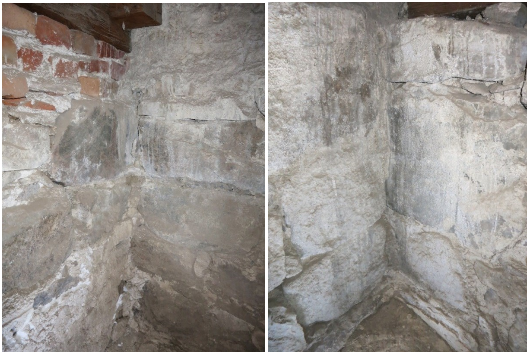
Figur 31. Till vänster. Skarven mellan långhuset till vänster och tornet till höger. Långhusets södra vägg går in bakom östra tornväggen, vilket gör att långhusväggen måste ha tillkommit före tornväggen. Foto ©Kulturen. Till höger. Skarven mellan långhuset till höger och tornet till vänster. Långhuset norra vägg går in bakom östra tornväggen, vilket innebär att långhusväggen måste ha tillkommit före tornväggen. Foto 2017 ©Kulturen.
