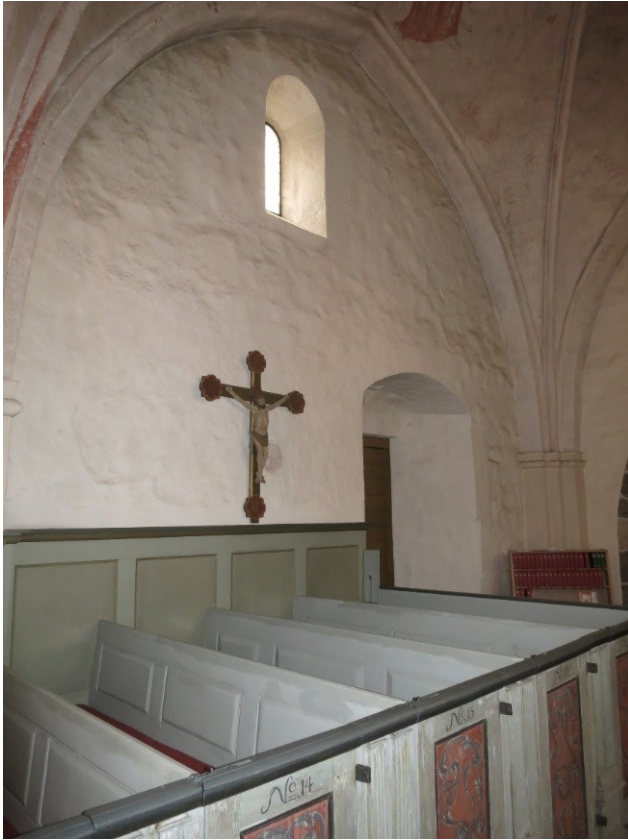
Figur 47. Fönster i långhusets södra vägg som tillkommit efter att valven i långhuset slogs på 1400-talet. Foto 2017 ©Kulturen.
