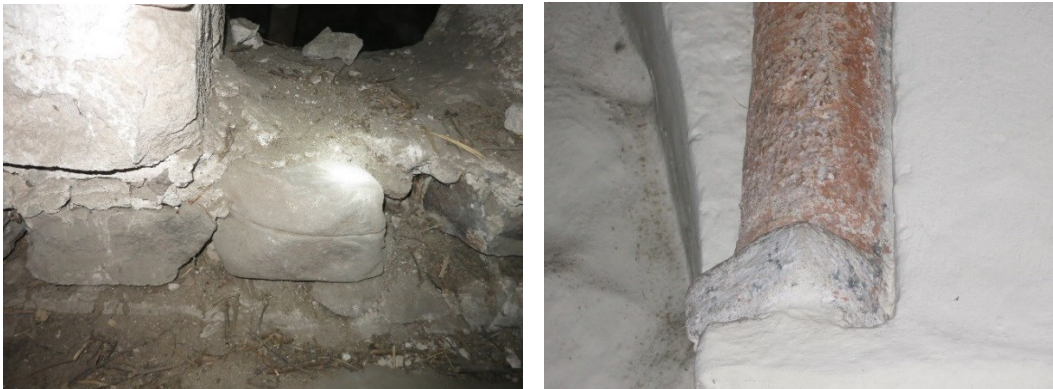
Figur 71. I grunden till portalomfattning mellan kor och absid på vinden, finns en sten, vänstra bilden, som troligen var tänkt att bearbetas exempelvis till en bas till en kolonnett, högra bilden. Ett inhugget spår runt stenen vittnar om var arbetet med att forma stenen kan ha varit tänkt att börja. Foto 2017 ©Kulturen.
