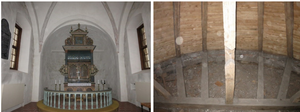
Figur 49. Till vänster. Absiden är försedd med ett hjälmvalv. Till höger. På vinden syns inte hjälmvalvet men väl takkonstruktionen. Foto 2017 ©Kulturen.
