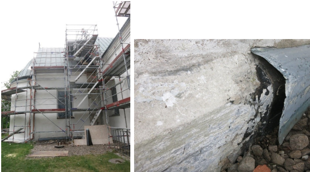
Figur 74. Till vänster. Korets sockel är skyddad av plåt. Till höger. Under plåten skymtar en sandstenssockel fram. Absidens sockel är putsad. Foto 2017 ©Kulturen.
