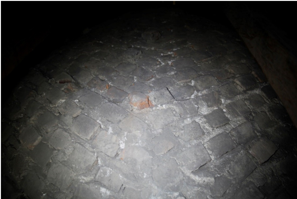
Figur 60. Valven i långhuset är murade på stick. Vilket innebär att i mötet mellan två sidor av en valvkappa bildas ett fiskbensmönster. Foto 2017 ©Camilla Melin, Knadriks Kulturbygg.
