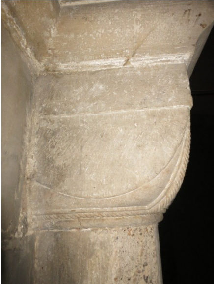
Figur 66. Kapitäl i Lunds domkyrkas krypta. Tärningskapitålet är dekorerat med repstavsornamentik. Foto 2017 ©Kulturen.
