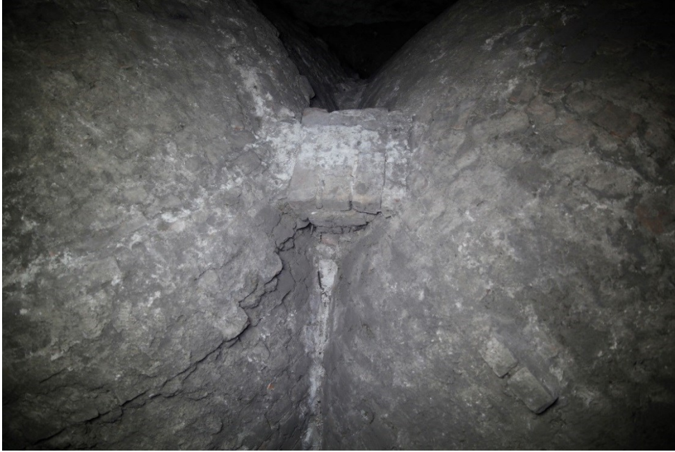
Figur 59. I sammanfogningen mellan de två valven över långhuset finns en plattform murad i tegel. Foto 2017 ©Camilla Melin, Knadriks Kulturbygg.
