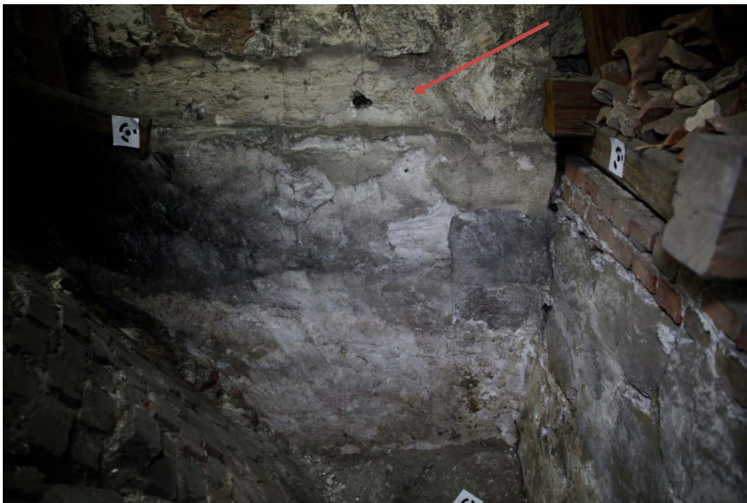
Figur 36. Detta fotografi visar långhusets östra vägg mot koret och anslutningen till den södra långhusmuren. I östra långhusväggen syns ett avtryck där bindbjälken i en äldre takstol suttit. Avtrycket syns vid den röda pilen. Foto 2017 ©Camilla Melin, Knadriks Kulturbygg.
