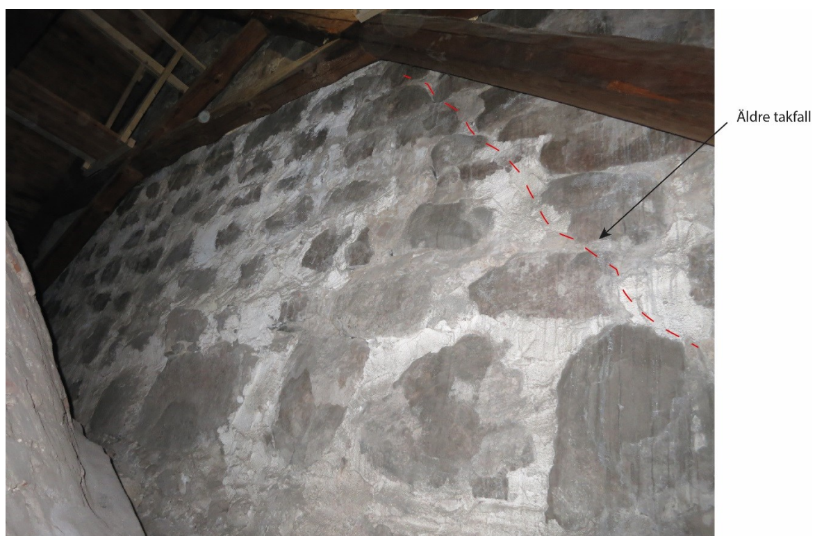
Figur 39. Långhusets gavlar har kompletterats med nytt murverk när takfallet ändrats. Foto 2017 ©Kulturen.
