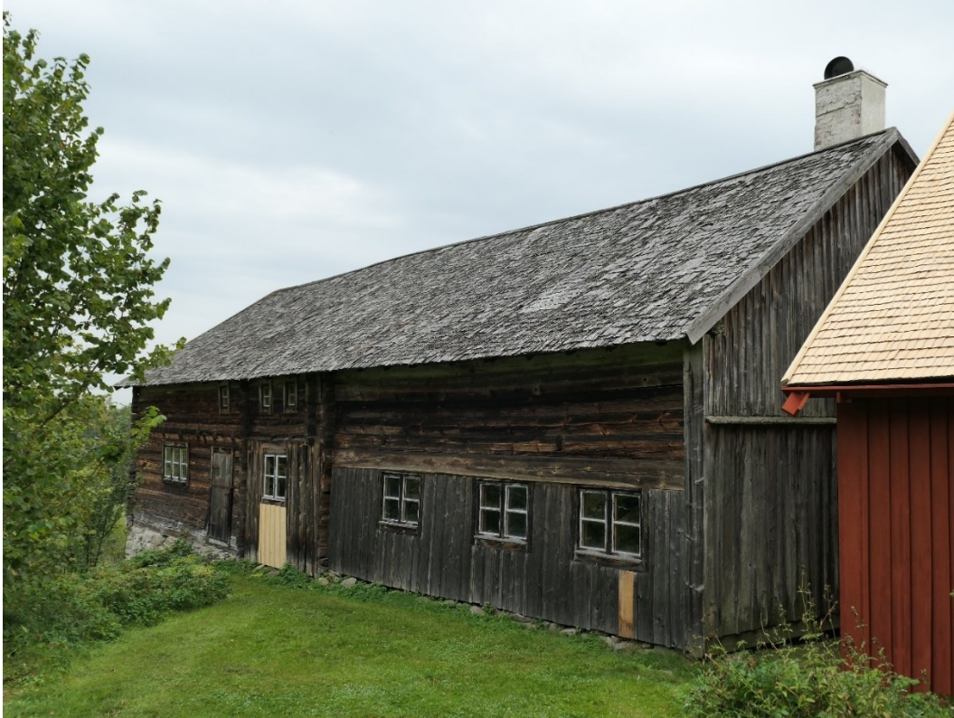
Före åtgärder. Boningslängans södra takfall.
