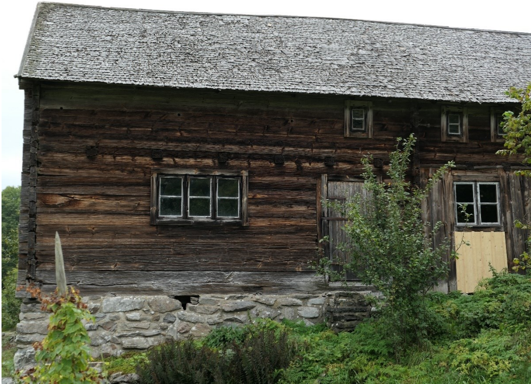
Före åtgärder. Boningslängans södra takfall.
