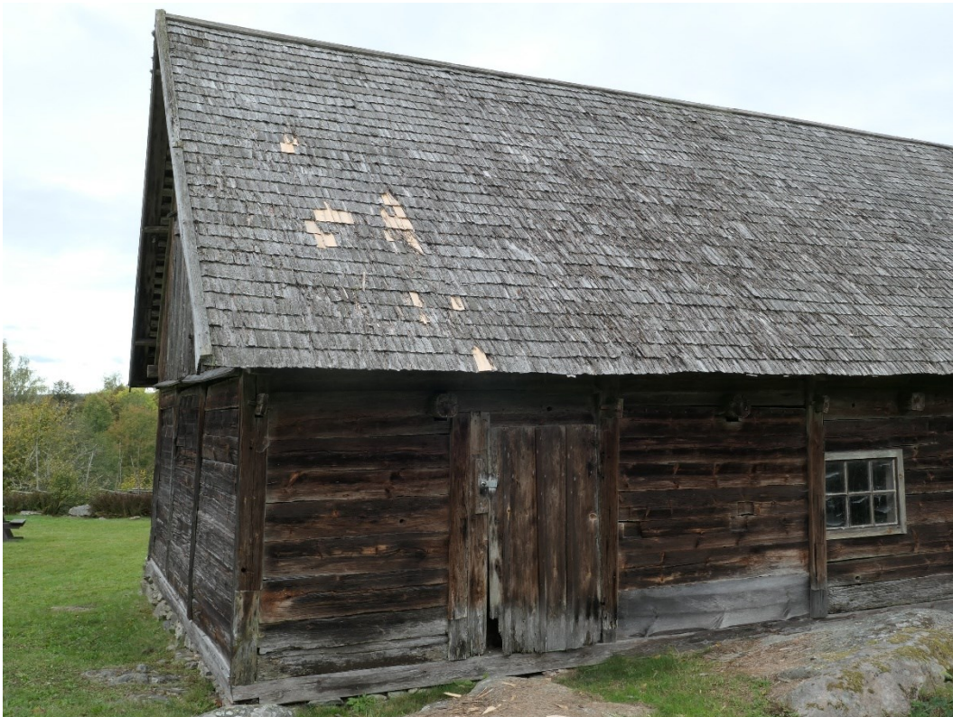
Östra ekonomibyggnaden med lagningar mot öster.
