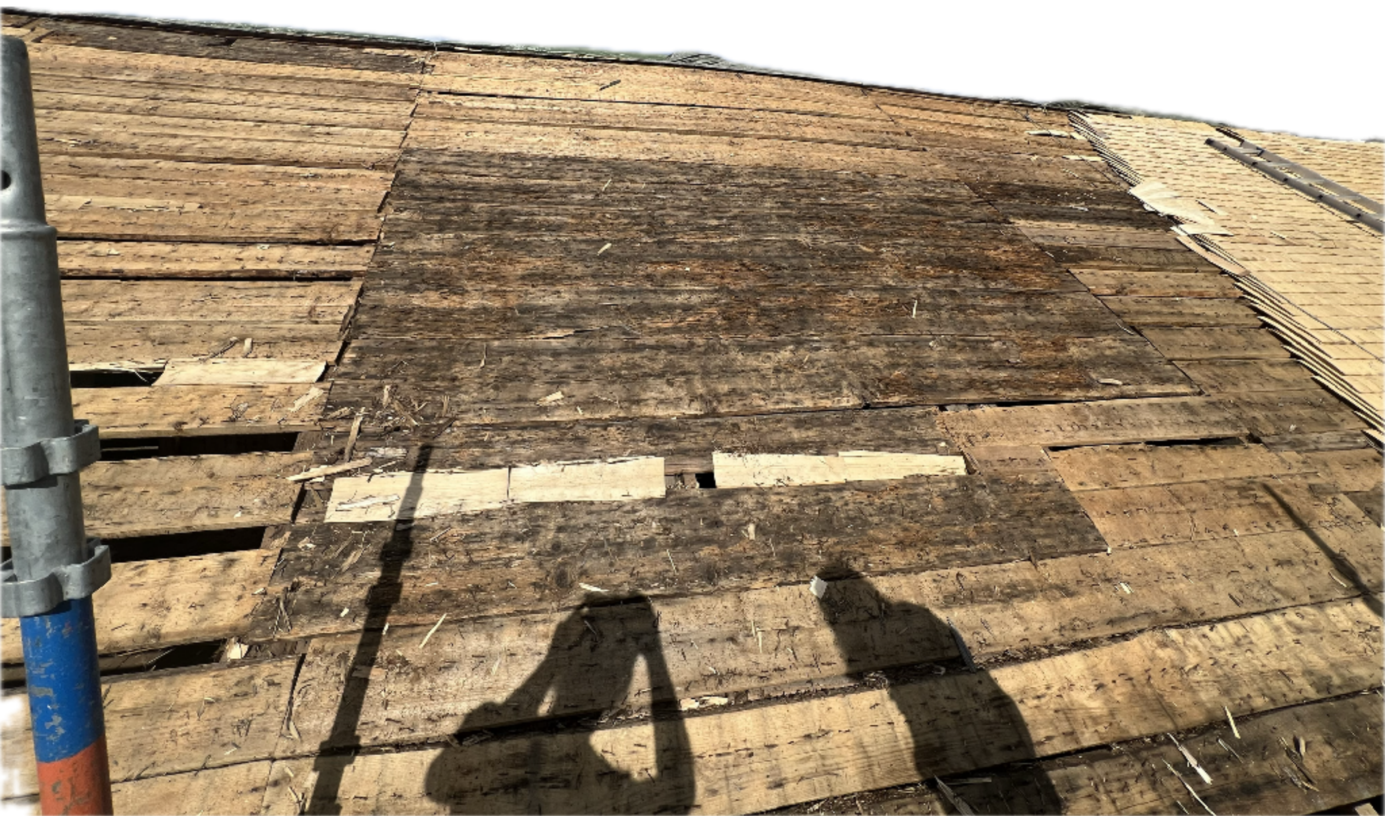
Södra takfallets västra halva
