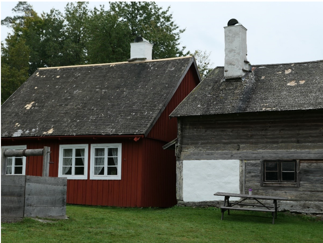
Före åtgärder. Till höger i bild, Boningslångans skorsten på norra takfallet.
