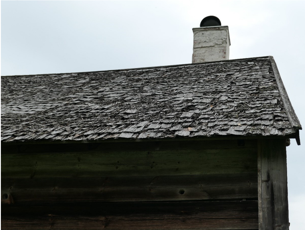
Före åtgärder. Boningslångans södra takfall.
