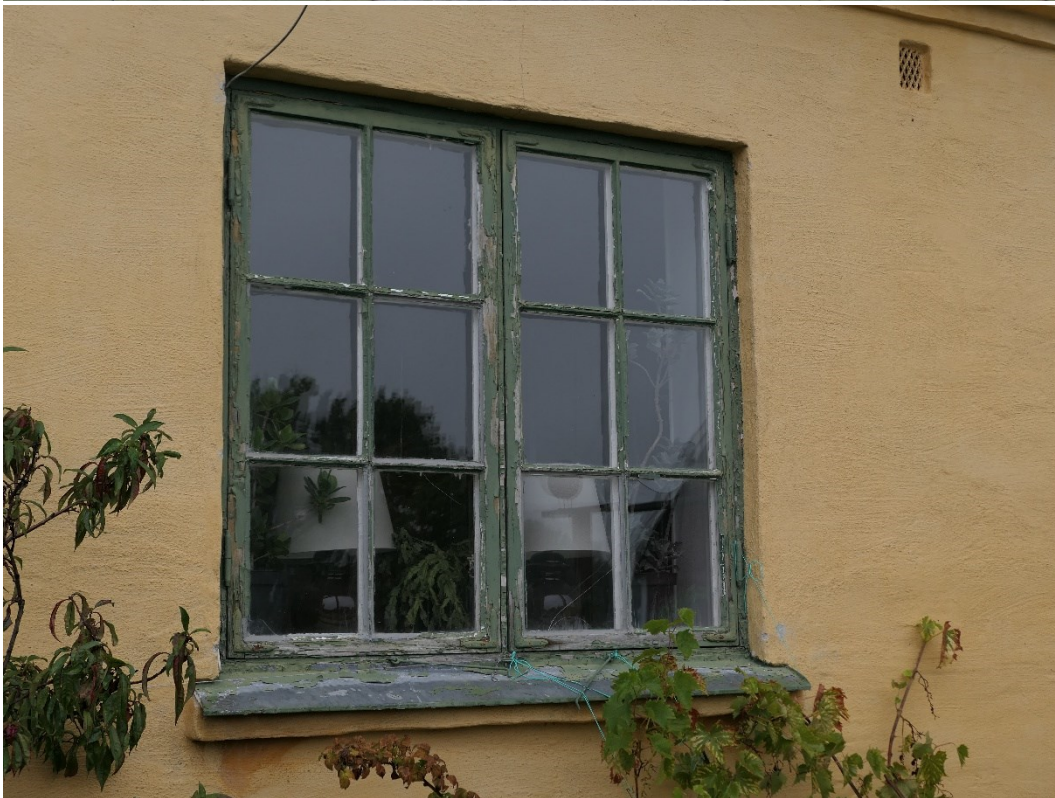
Före åtgärder. Exempel på fönster.
