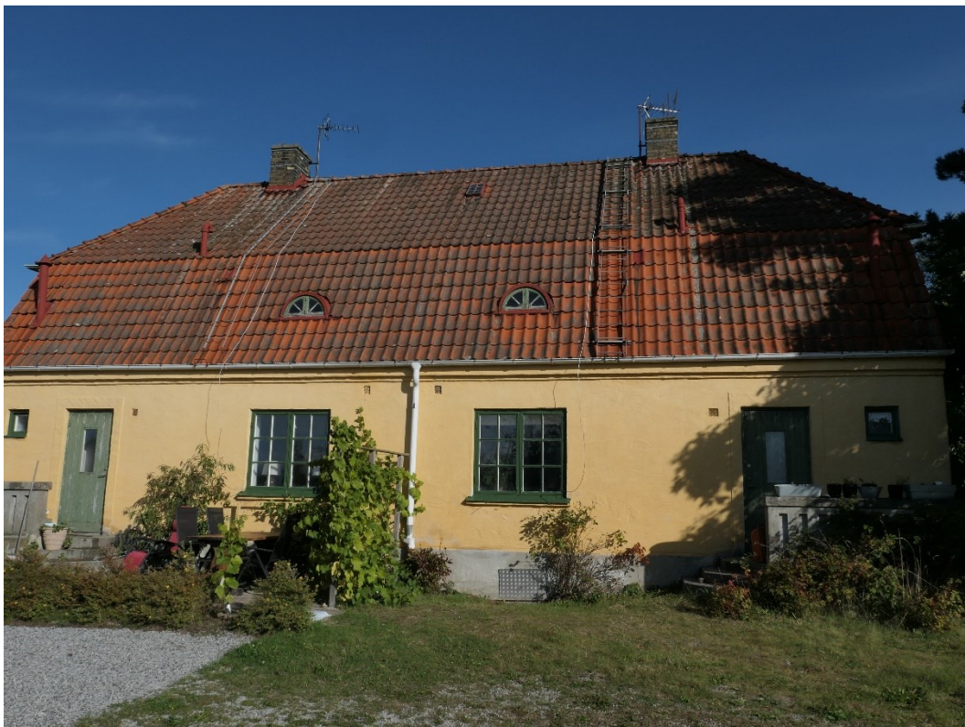
Efter åtgärder byggnad 1817 – 1818.
