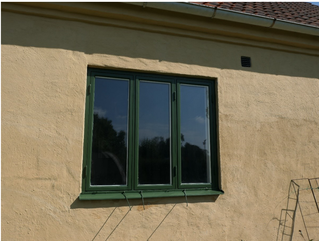
Efter åtgärder. Exempel på fönster. Glasrutan längst i höger är ersatt med nytt valsat glas.
