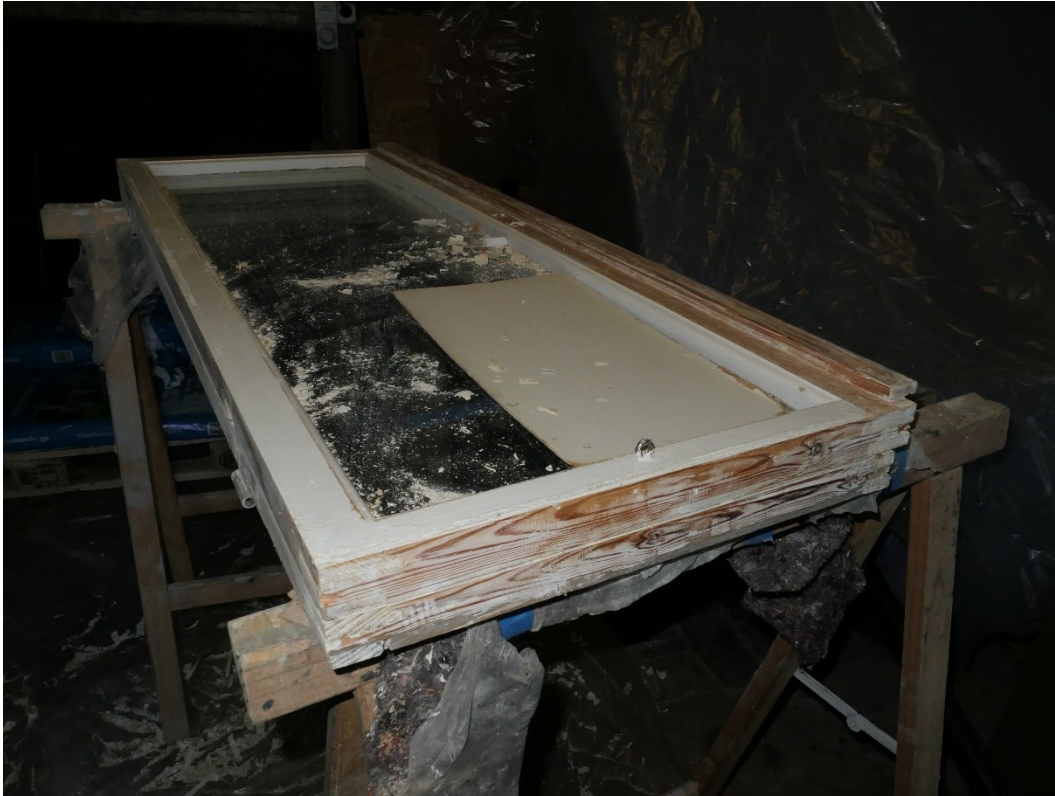
Under arbete, fönster från byggnad 1827 – 1829.
