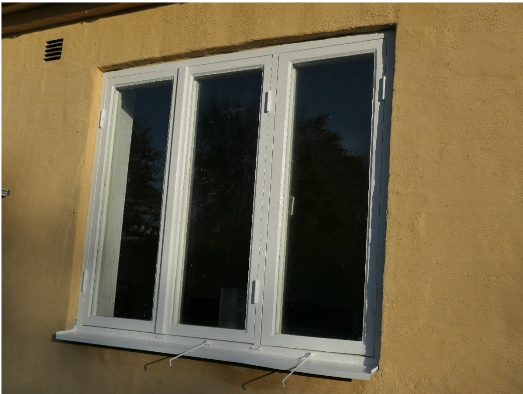
Efter åtgärder, exempel på fönster i byggnad 1827, 1828, 1829.
