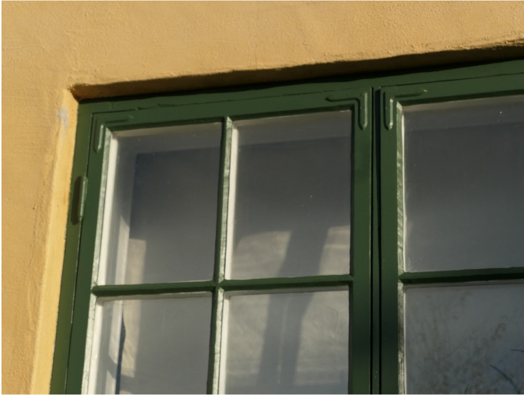
Efter åtgärder. Exempel på fönster.
