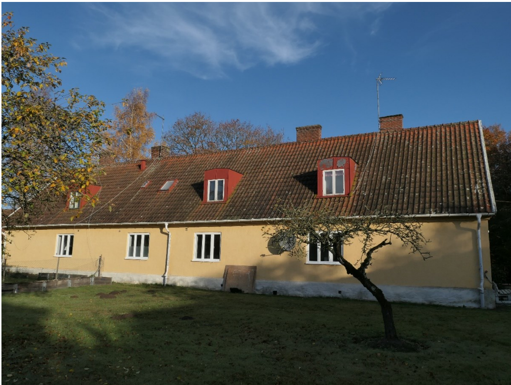
Efter åtgärder byggnad 1827, 1828, 1829.
