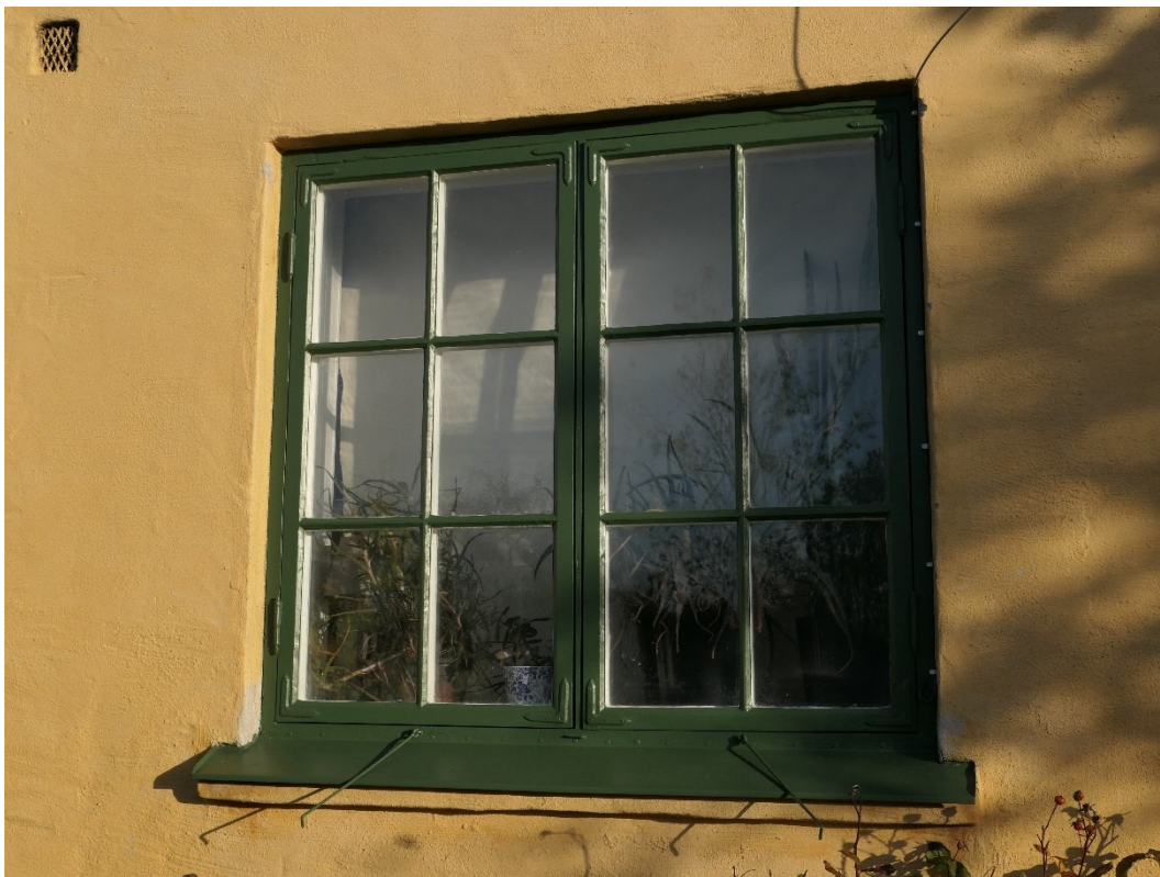
Efter åtgärder. Exempel på fönster.
