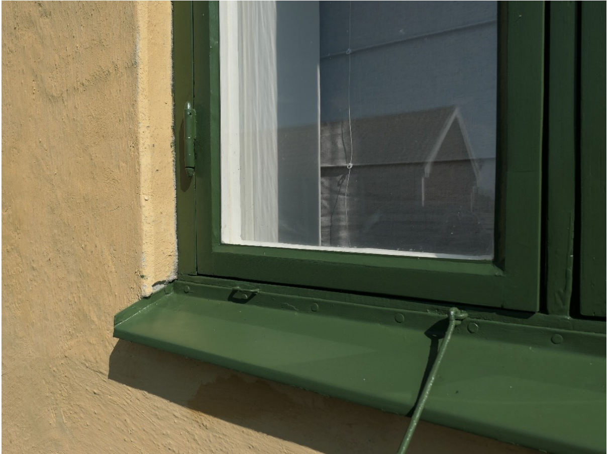
Efter åtgärder. Exempel på fönster. Bågens högra nedre hörn är skarvat med nytt virke.
