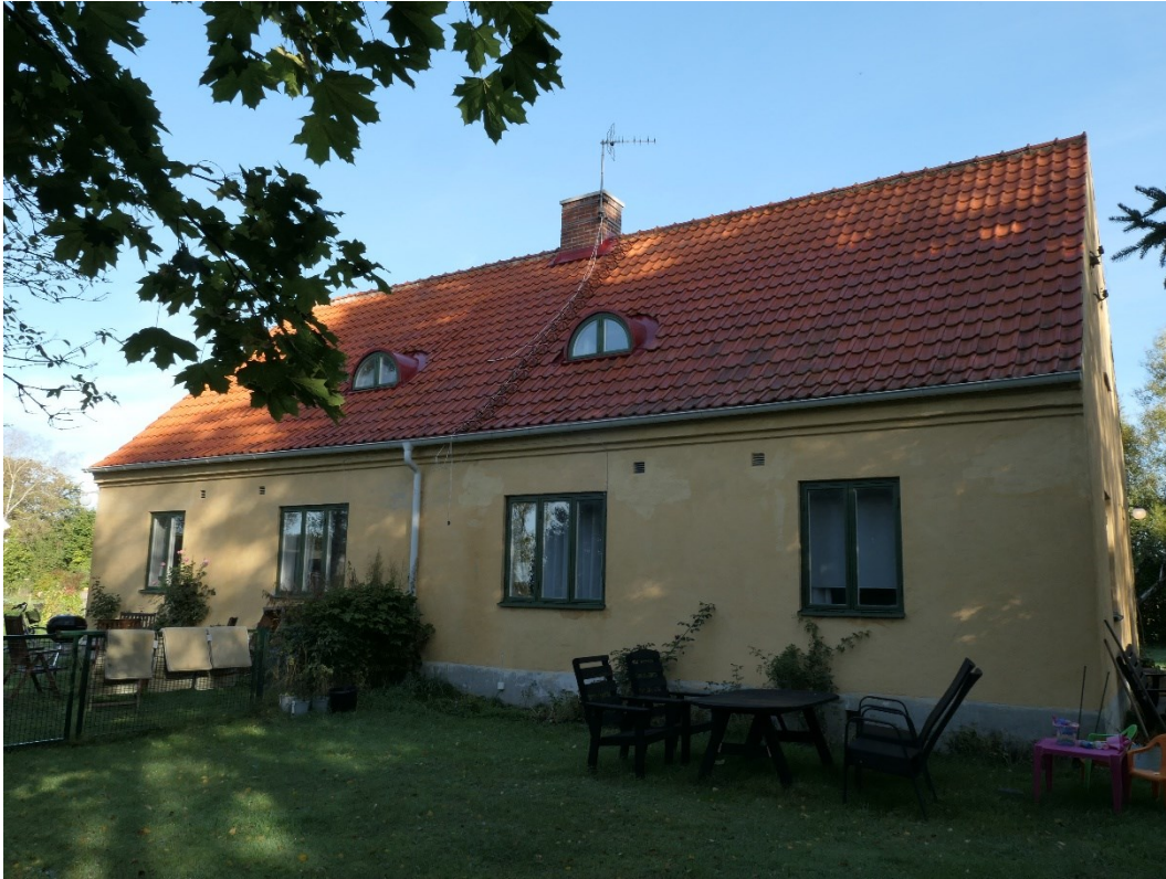
Efter åtgärder byggnad 1825 – 1826.
