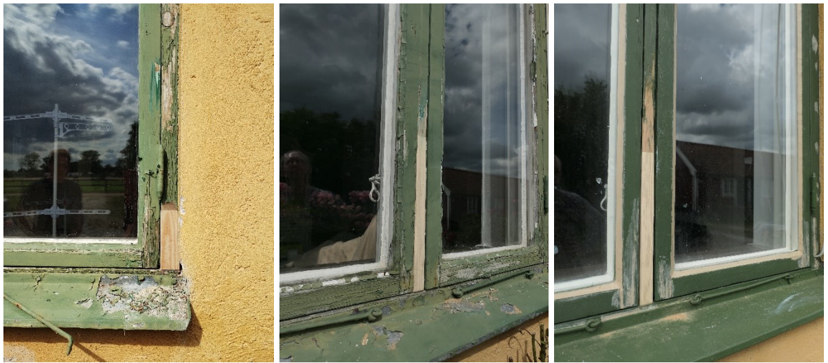
Under arbete. De nedre bilderna visar exempel på trälagningar.
