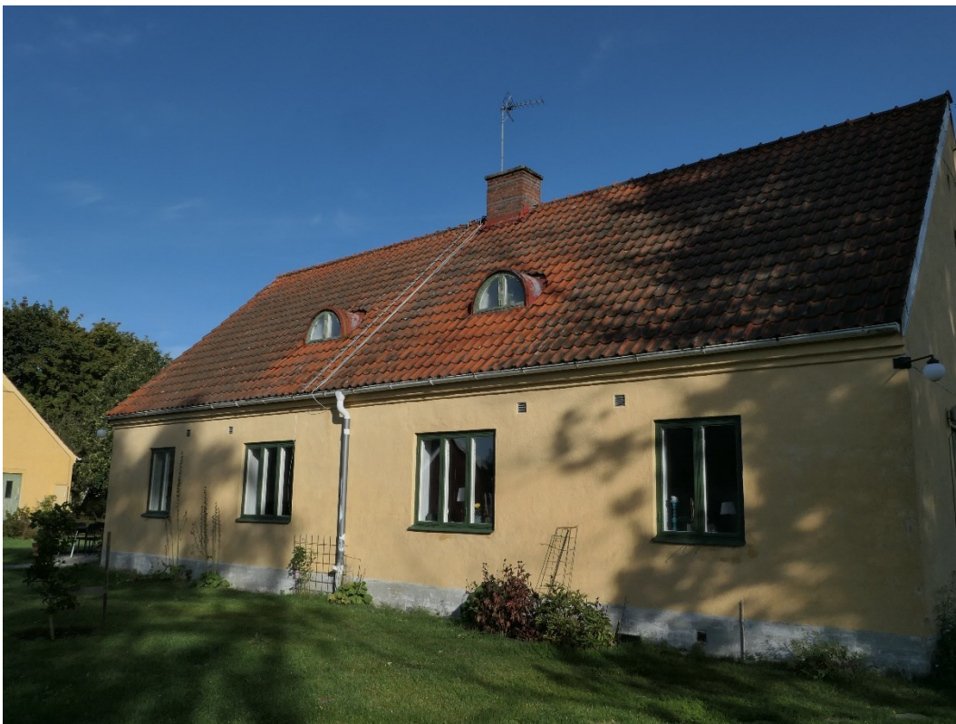
Efter åtgärder byggnad 1823 – 1824.
