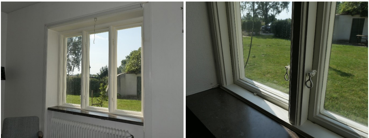
Efter åtgärder. Exempel på fönster invändigt.
