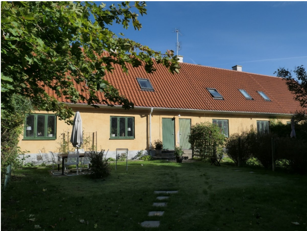
Efter åtgärder byggnad 1811 – 1814.
