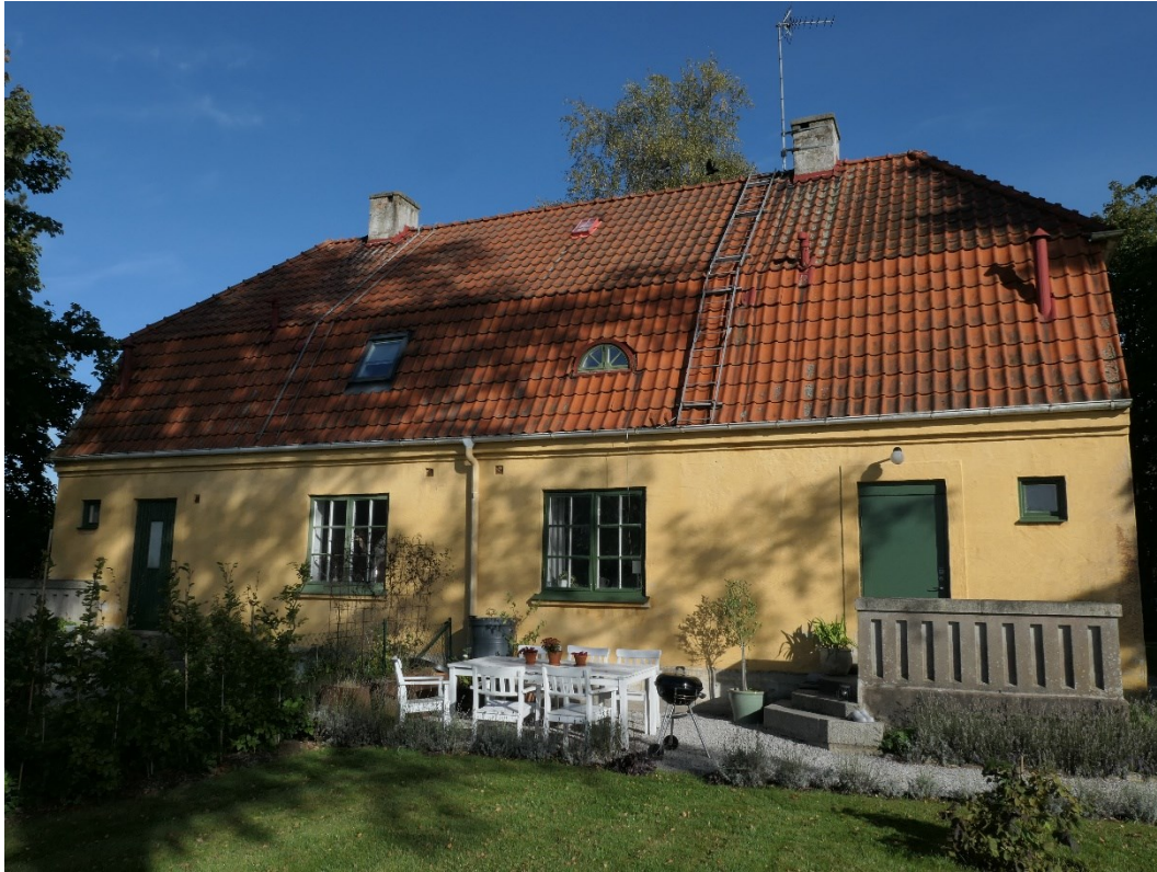
Efter åtgärder byggnad 1816 (de två fönstren längst till vänster i bild var redan renoverade och ingick inte i arbetet).
