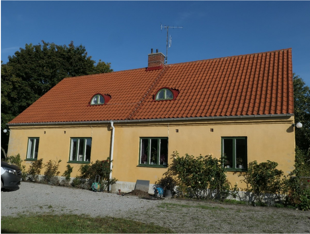
Efter åtgärder byggnad 1821 – 1822.
