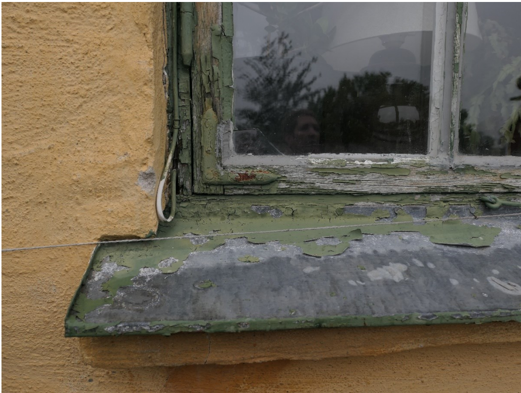
Före åtgärder. Exempel på fönster.
