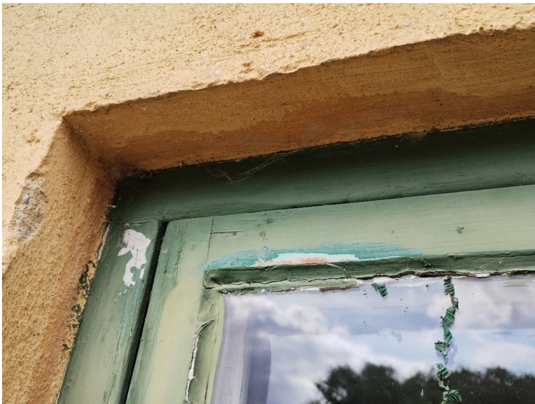
Under arbete, spår av vitt färgskikt på karmen under gröna färglager.
