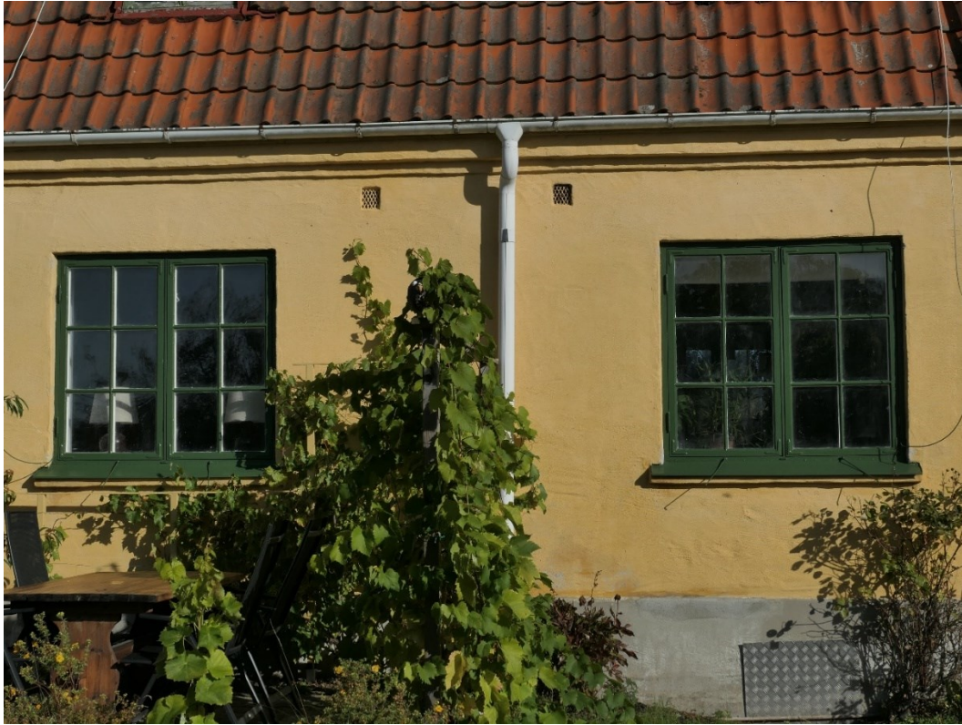
Efter åtgärder. Exempel på fönster.
