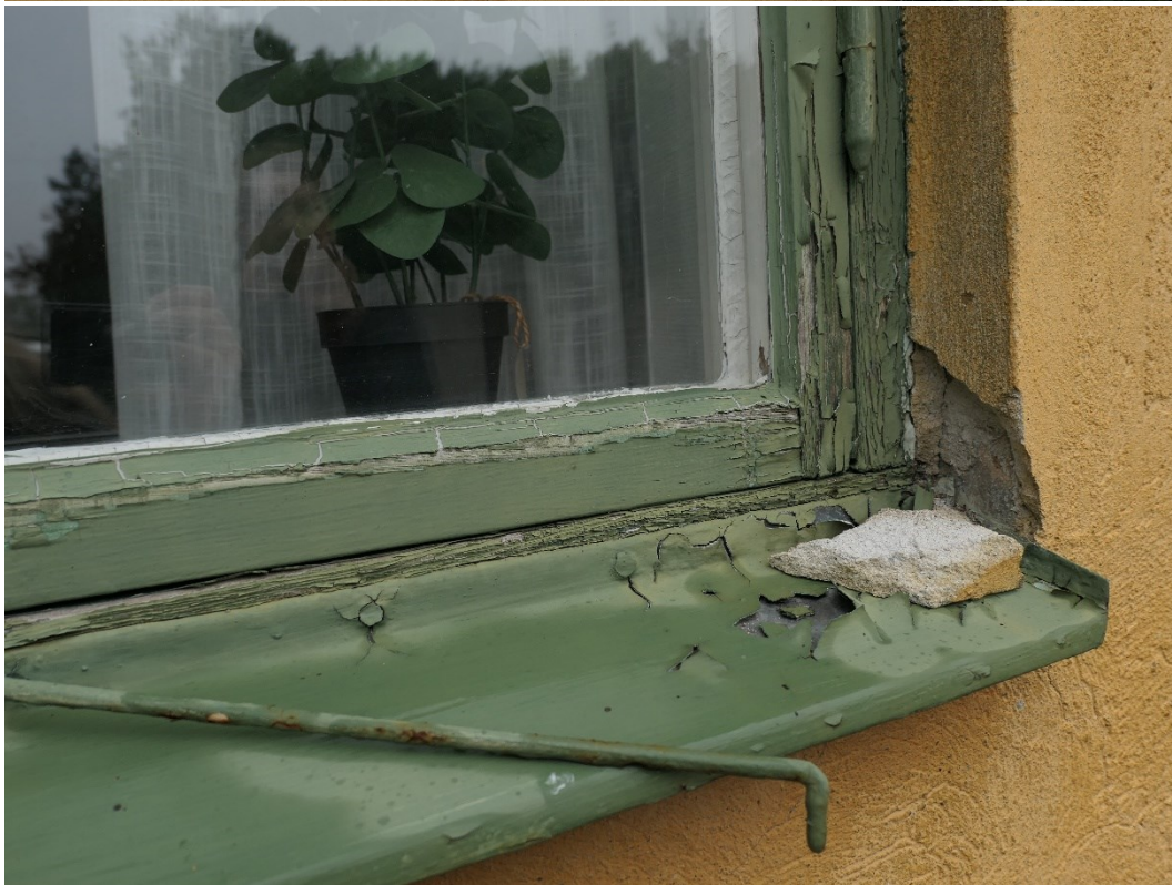
Före åtgärder. Exempel på fönster.
