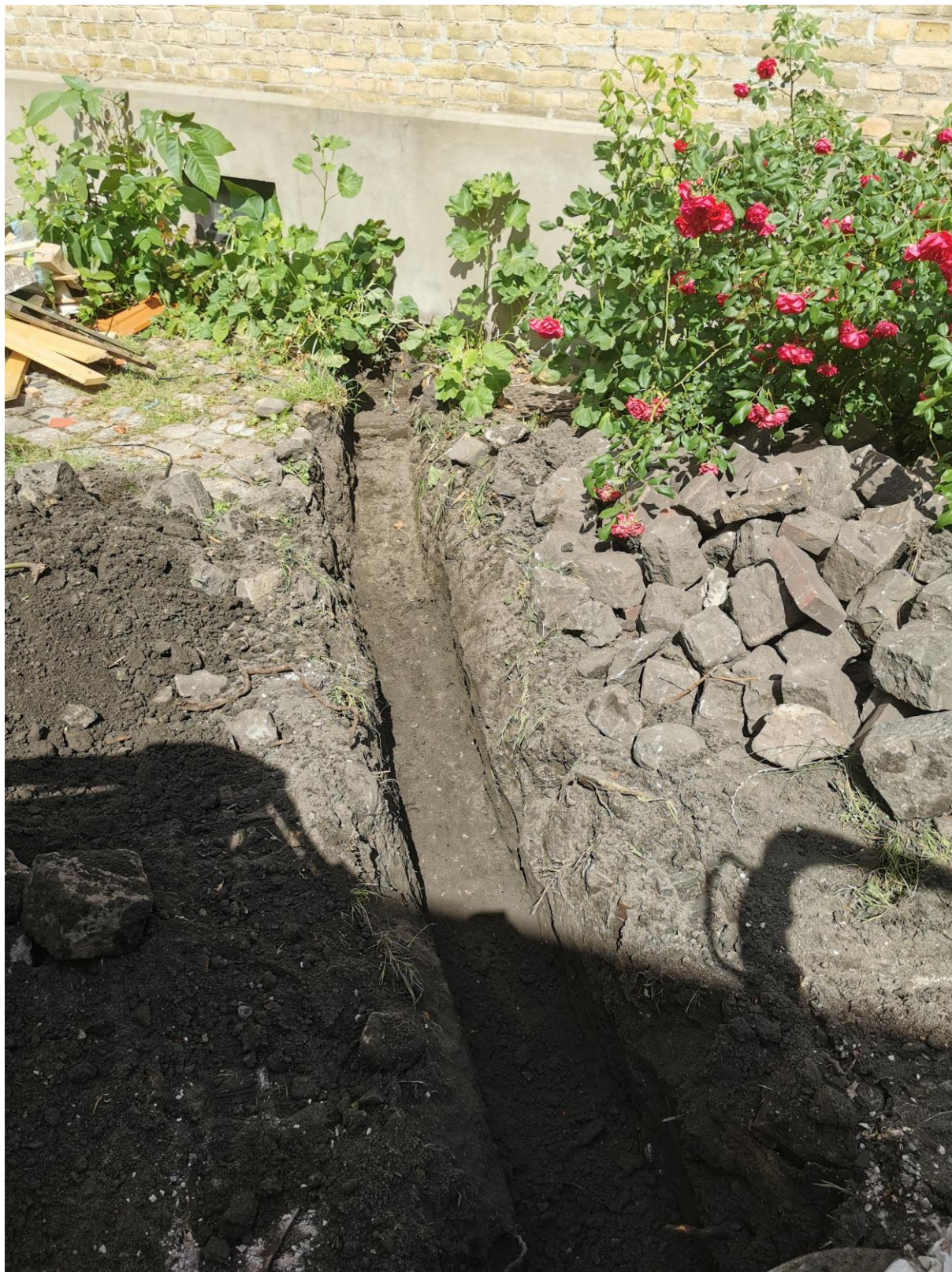
Figur 9. Schakt 2 översikt. Schaktet grävdes för att ansluta ledningar till nybyggnation. Fotografi taget från syd.
