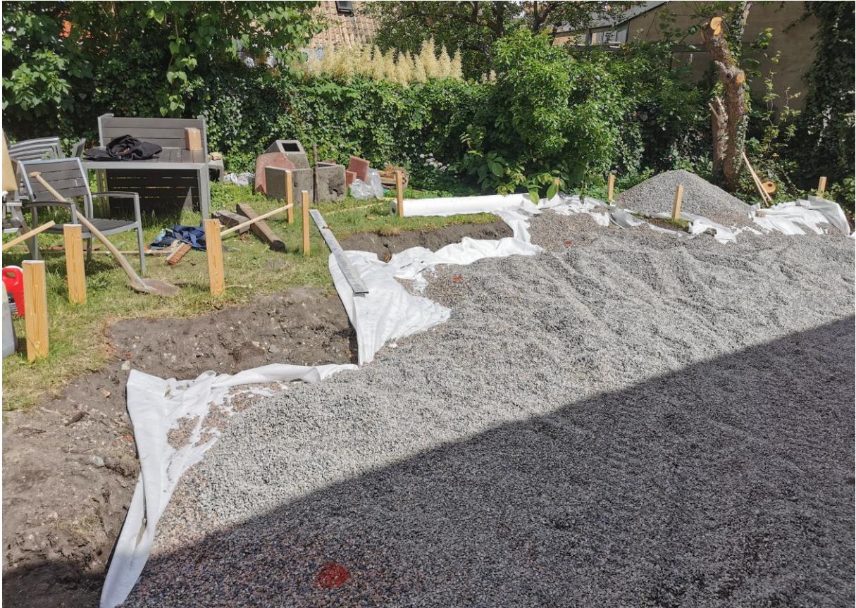
Figur 6. Schaktet täckt med geotextil och fyllt med grus. Fotografi taget från syd.
