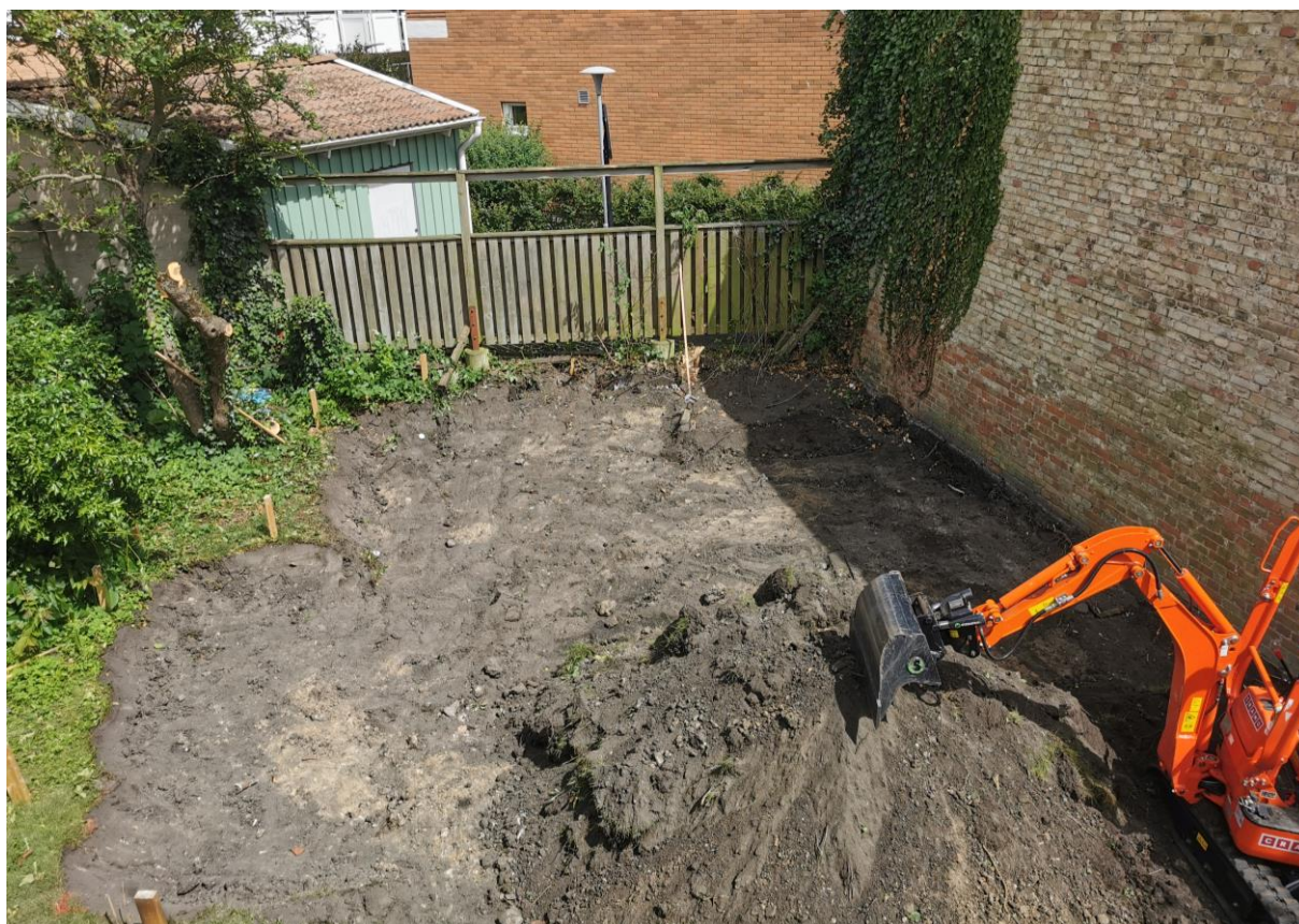
Figur 5. Påbörjad schaktning inför grundläggningsarbete. Fotografi taget från väst. De ljusa fläckarna i schaktbotten var en lerig silt (K102) som tolkades vara utlagt i samband med nybyggnationer i området under 1800-talets andra hälft.
