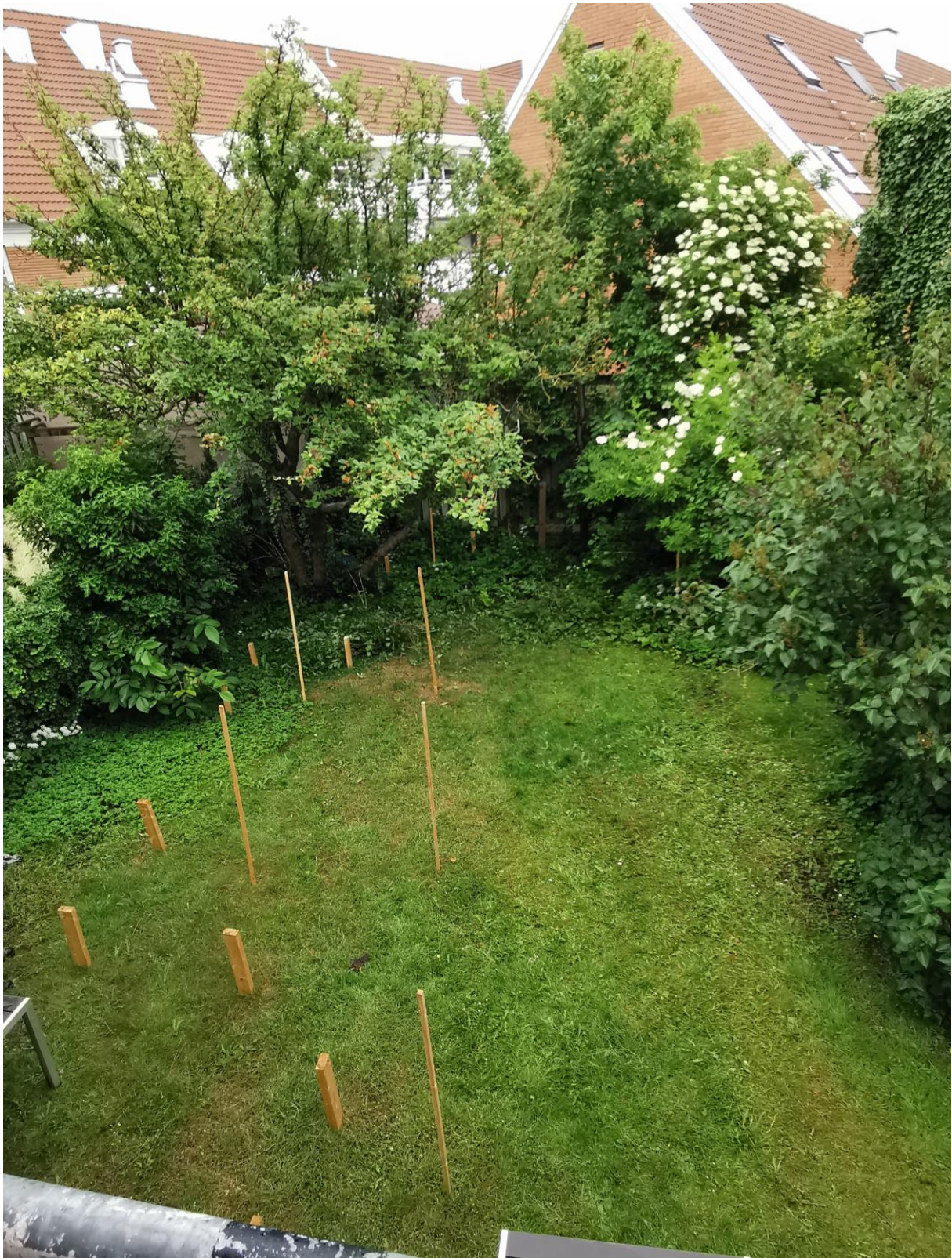
Figur 4. Översiktsbild från innergården till Billegården 25 innan röjningsarbetet påbörjades. Pinnar hade satts ut längs med schaktets norra utsträckning. De korta pinnarna var utsatta vid den tilltänkta schaktgränsen. De långa pinnarna var utsatta där husgrunden var planerad. Fotografi taget från väst.
