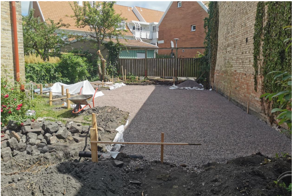
Figur 7. Det grusbelagda schaktet fotograferat efter markkomprimering. Foto taget från väst.
