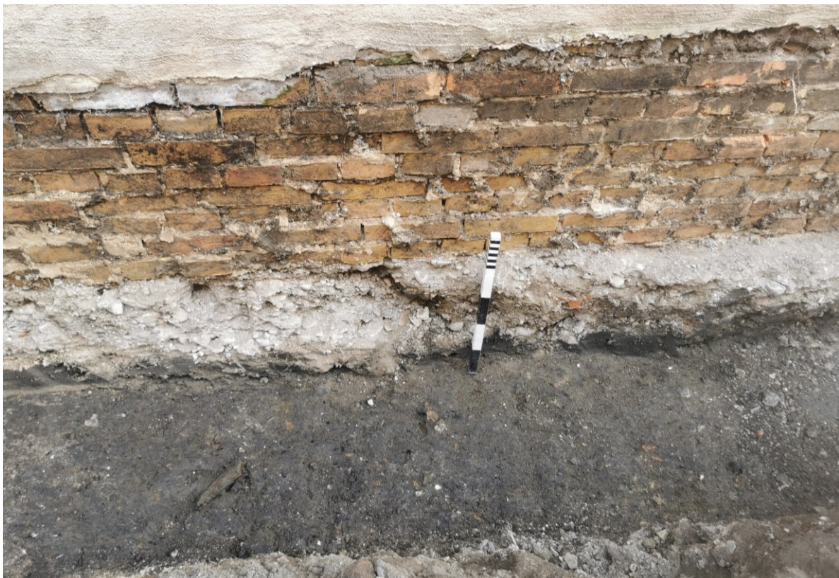
Figur 9. Översiktsfoto av muren för den norra byggnaden, med underliggande gruslager (K107) och i schaktbotten kan mörka kulturlager ses (K108). Fotografiet taget från söder.
