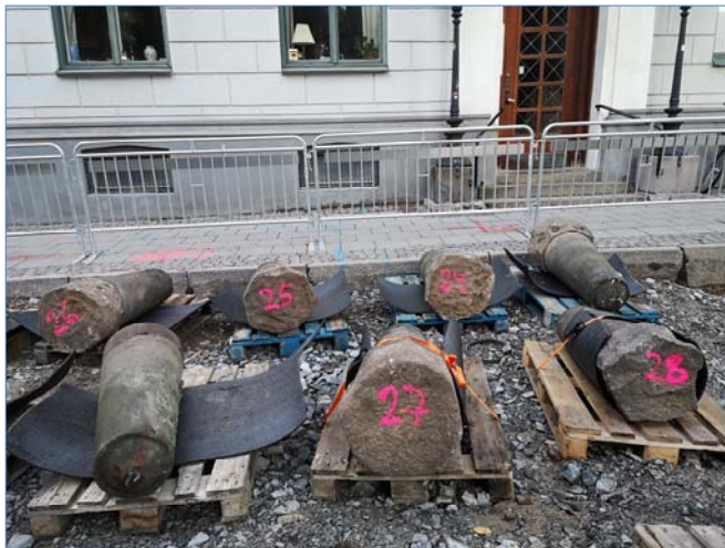
Figur 31. Stenpollarna öster om Kyrkogatan togs bort år 2019 och renoverades för att åter sättas upp 1 m österut år 2021.
