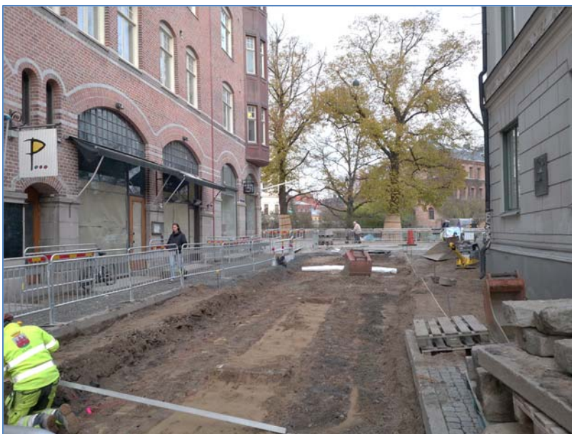
Figur 27. Vy över markarbetena med ett maximalt djup ner till 0,50 m på Lilla Gråbrödersgatan mot korsningen Kyrkogatan. Strimmor av intakt kulturjord dokumenterades. Fotografiet är taget mot nordöst.
