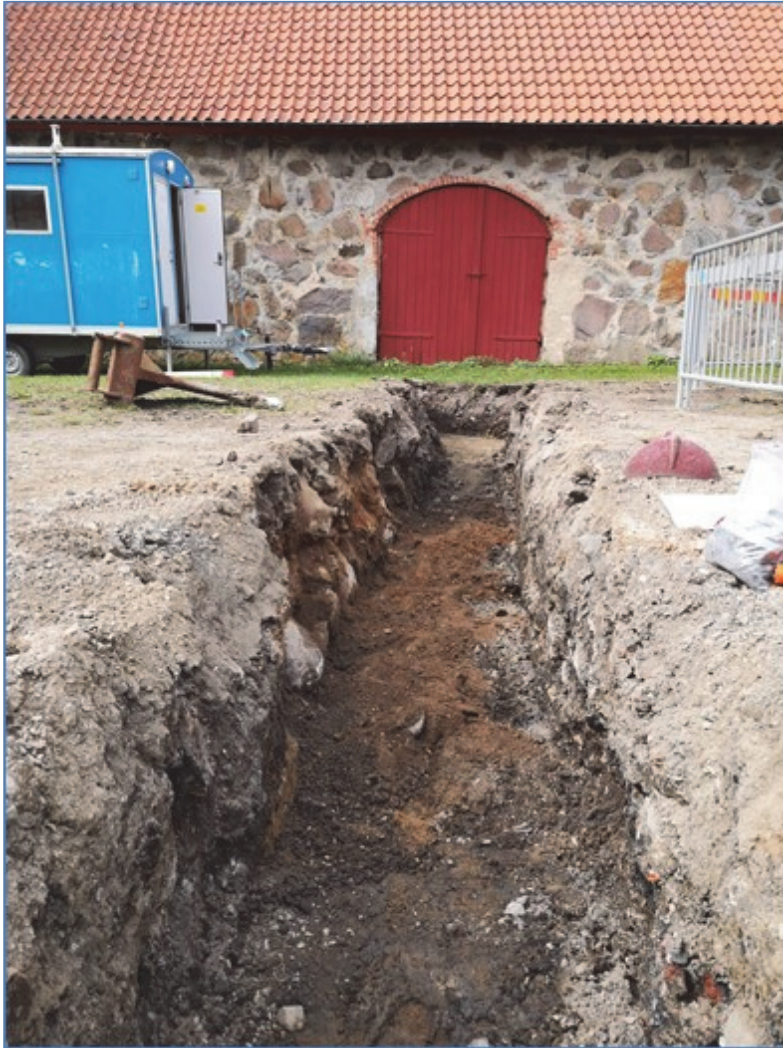
Figur 10. Området närmast i bild tillhör fyllnadsmassor i ett akutschaktat område kring en modern brunn. Väster om schaktet framkom stora stenar i orangebrunfärgat grus, vilket tyder på att en stor nedgrävning förekommit i området tidigare (K28–30, 181–182).
