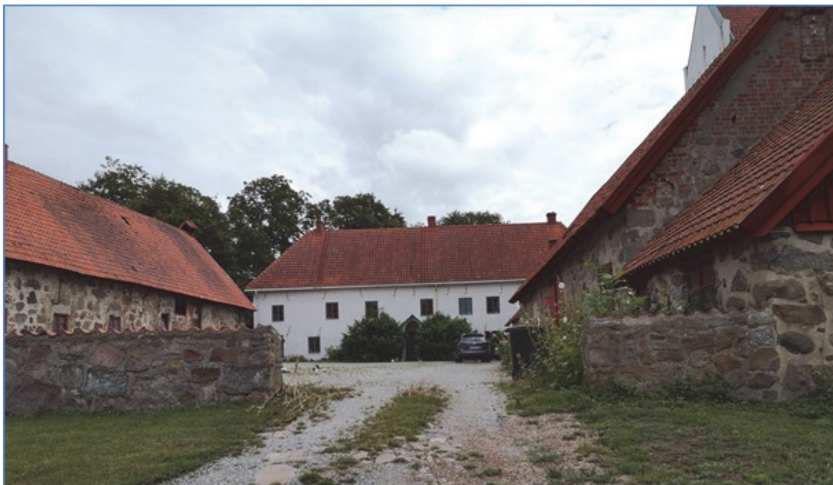
Figur 4. Den vita byggnaden längst bort i bild är den sista kvarvarande västra delen i den medeltida klosteranläggningen. Idag fungerar byggnaden som en bostad för arrendatorn till Dalby kungsgård. Byggnaden närmast till höger i bild kallas för Magasinet och kan ha uppförts under 1300-talet. Byggnaden till vänster i bild kallas för Ungdjursstallet. Fotografi från väster år 2020.
