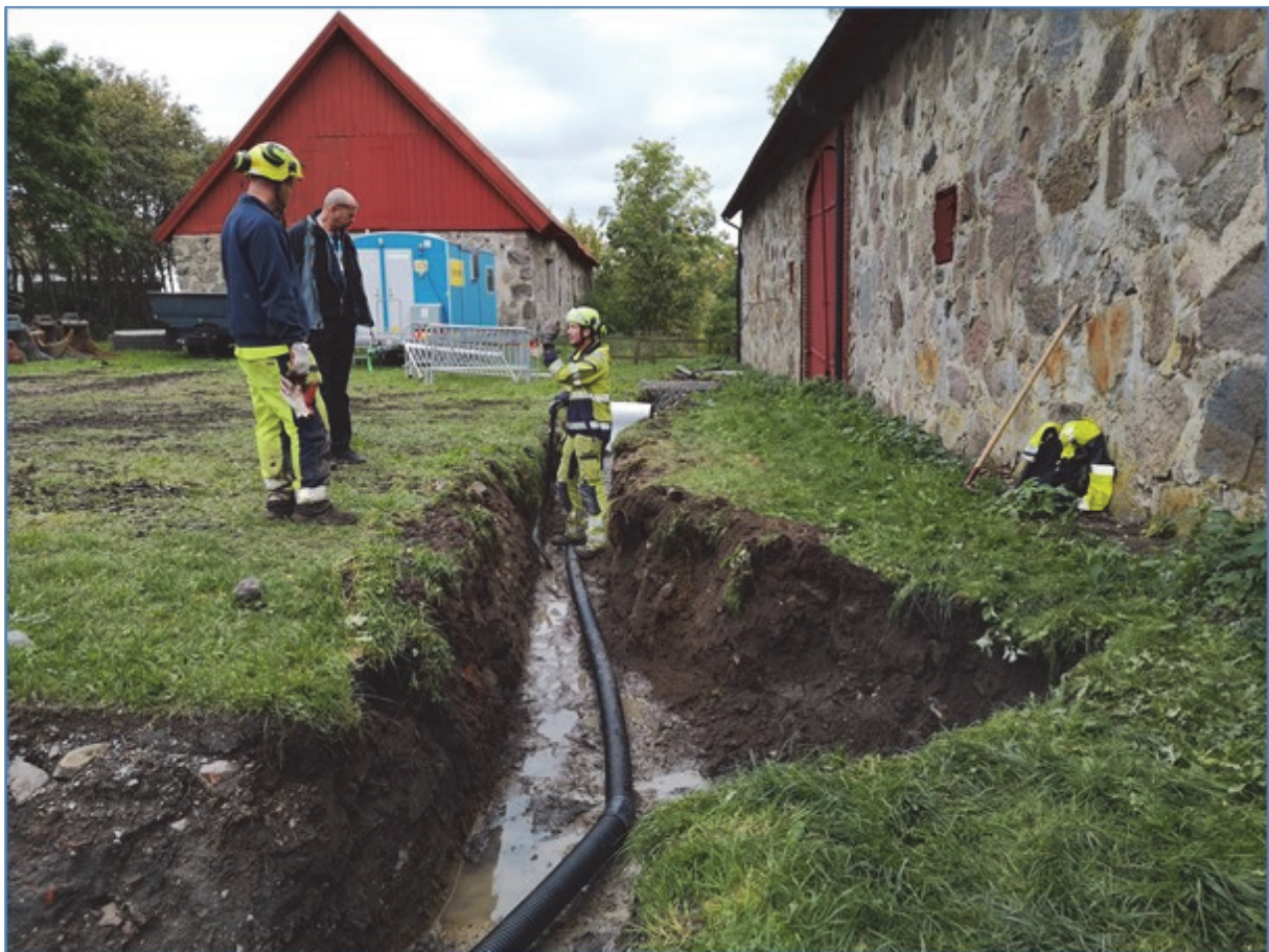
Figur 11. Ett kompletterande schakt för att sätta en radonbrunn och för att ansluta dränering genomfördes från den västra ekonomilängan och söderut. Personal från NCC. Fotografi taget ifrån norr.
